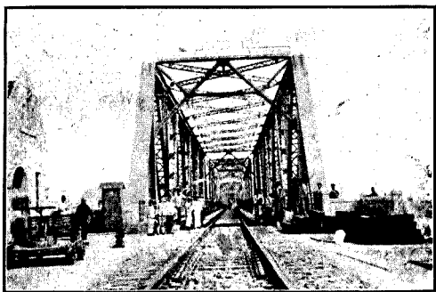
灤 口 黃 河 鐵 橋
