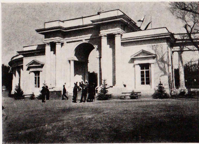
Деталь главнаго входа со стороны территоріи Выставки.
