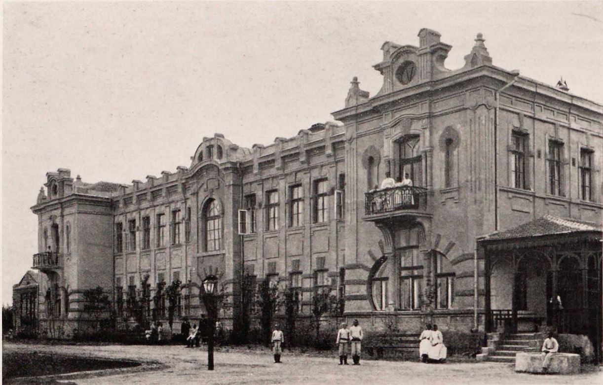
Зданіе Школы Попечительства о глухонѣмыхъ въ г. Александровскѣ.
