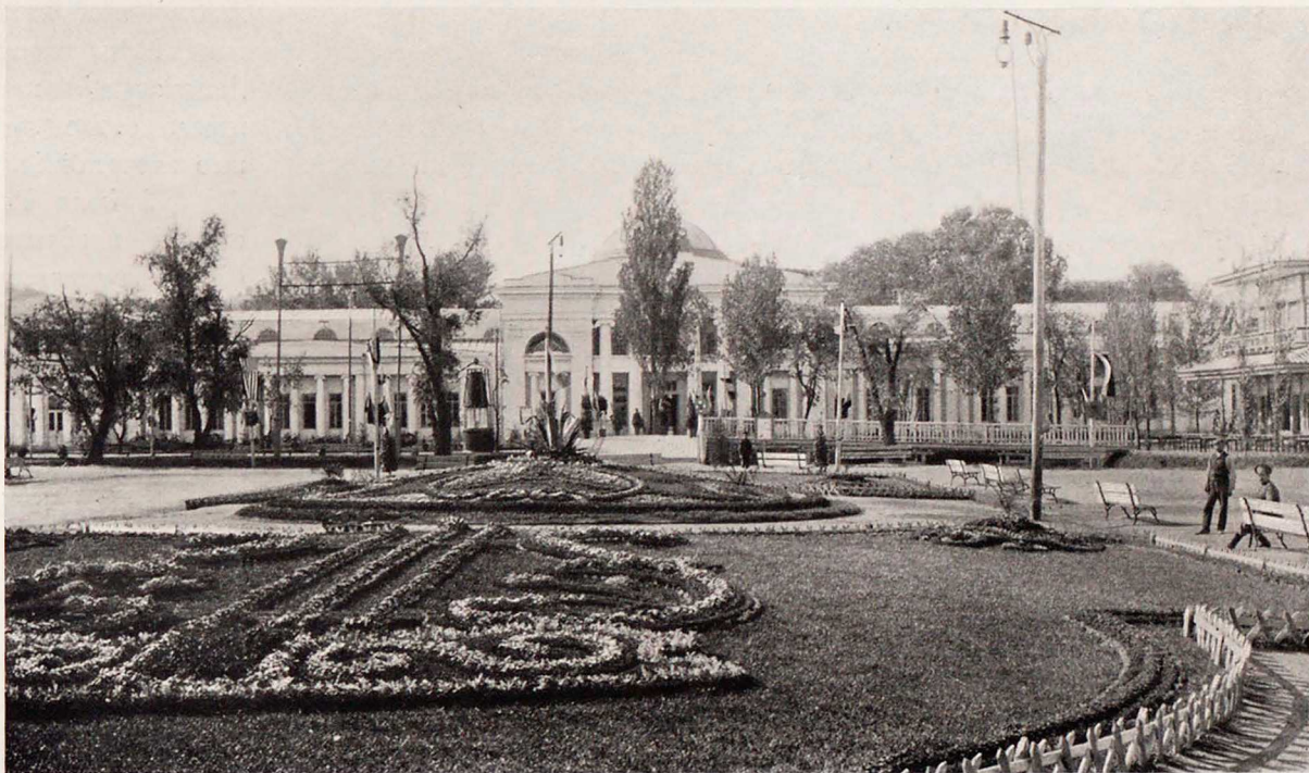
Видъ на главный павильонъ отъ фонтана.
