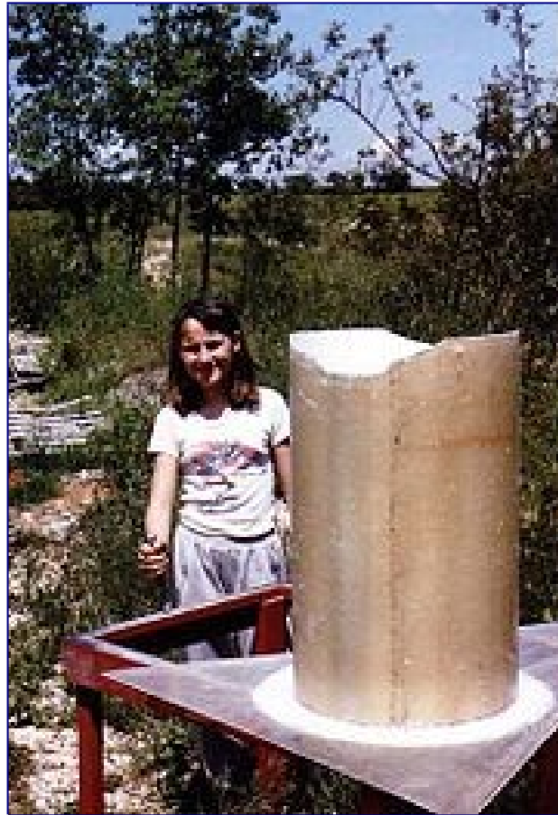
Préparation du puits à chaîne avant la pose de la cloison étanche.
