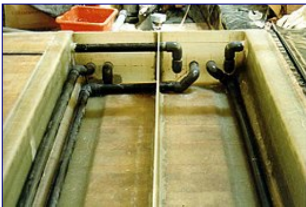
Pose des canalisations de remplissage et de vidange. Finition à la peinture époxy.
