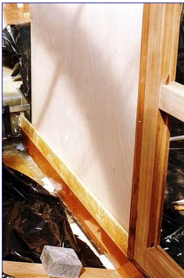
Pose de la cloison entre le carré et la cabine N°2. (cabine centrale)
