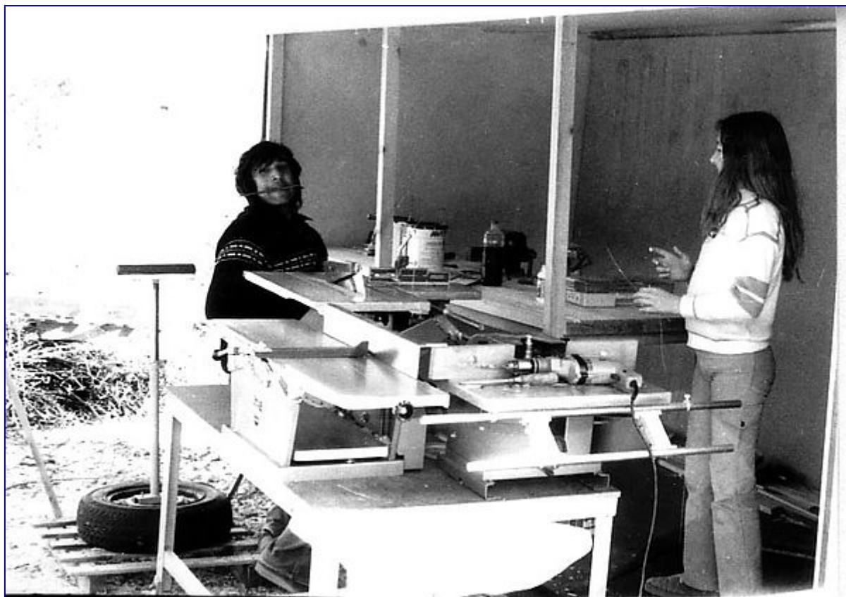
Exemple d'atelier de chantier. Au minimum un ensemble dégauchisseuse-raboteuse, scie circulaire, toupie et perceuse à colonne.
