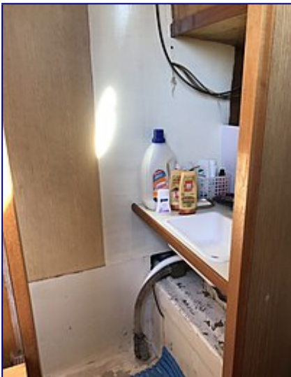
Douche en rénovation
