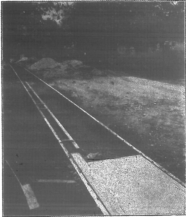
混凝土側石及側溝之模板
