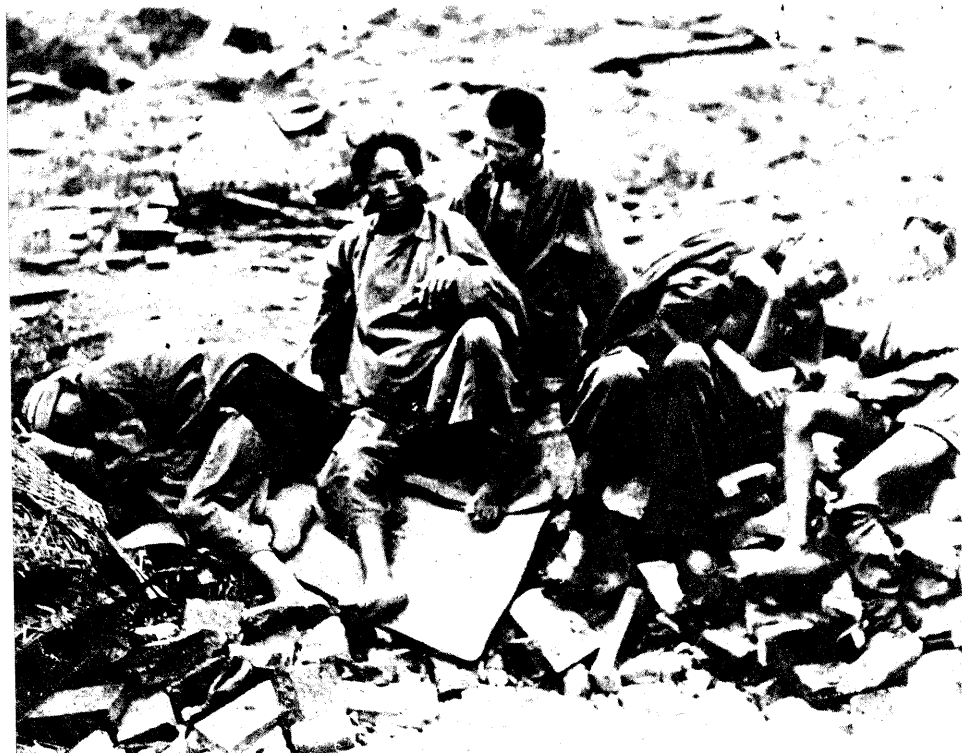
江 北 民 衆 在 破 毀 家 屋 前 露 宿 情 形
