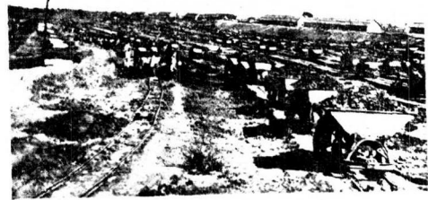
(四) 三河活動壩挖土工程
