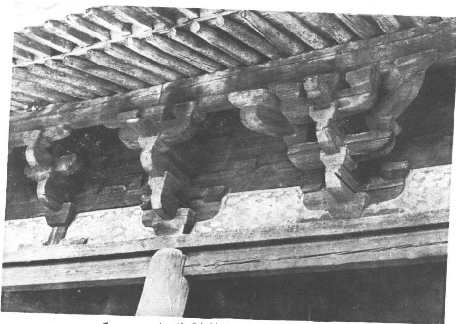
乙 木塔副階柱頭及補間鋪作
