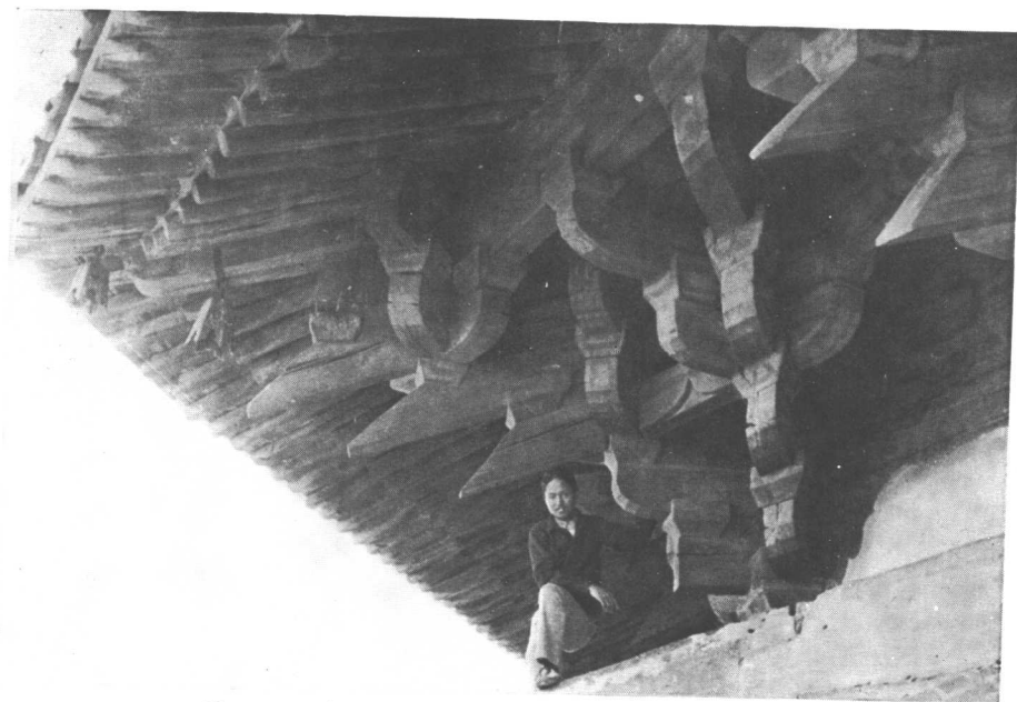
甲 木塔第一層轉角鋪作
