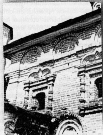
Верх-Боровое. Воздвиженская церковь. Окна второго этажа
