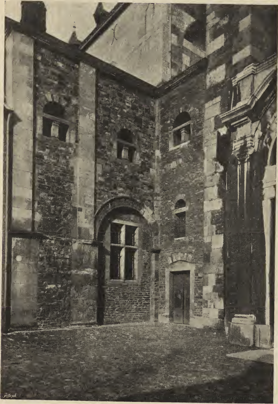
Abb. 41. Aachen, Dom: Nordostecke des Atriums. Nach der Restauration.
