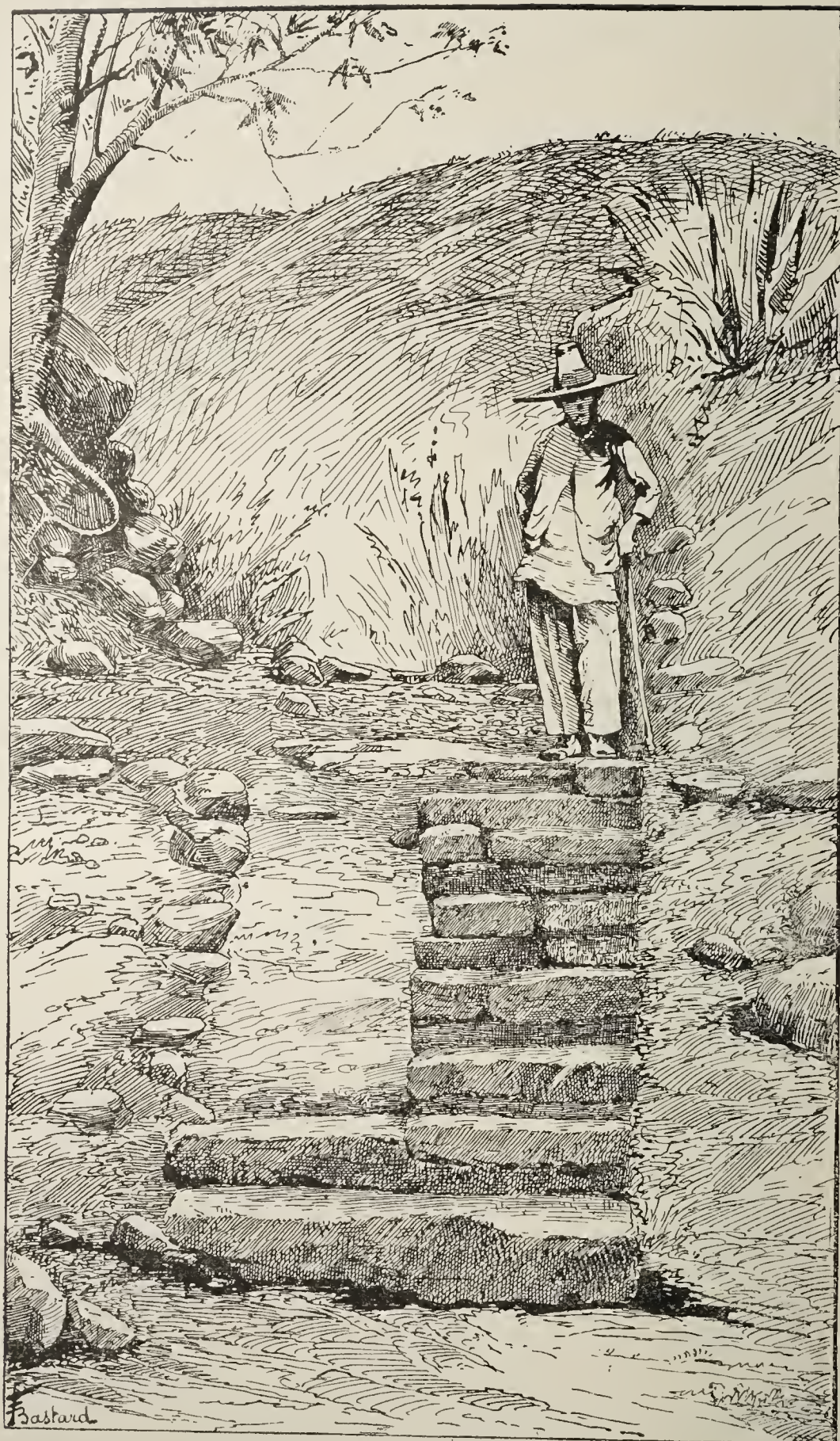
FIG. 2. — Vue de l'escalier, du côté nord.
