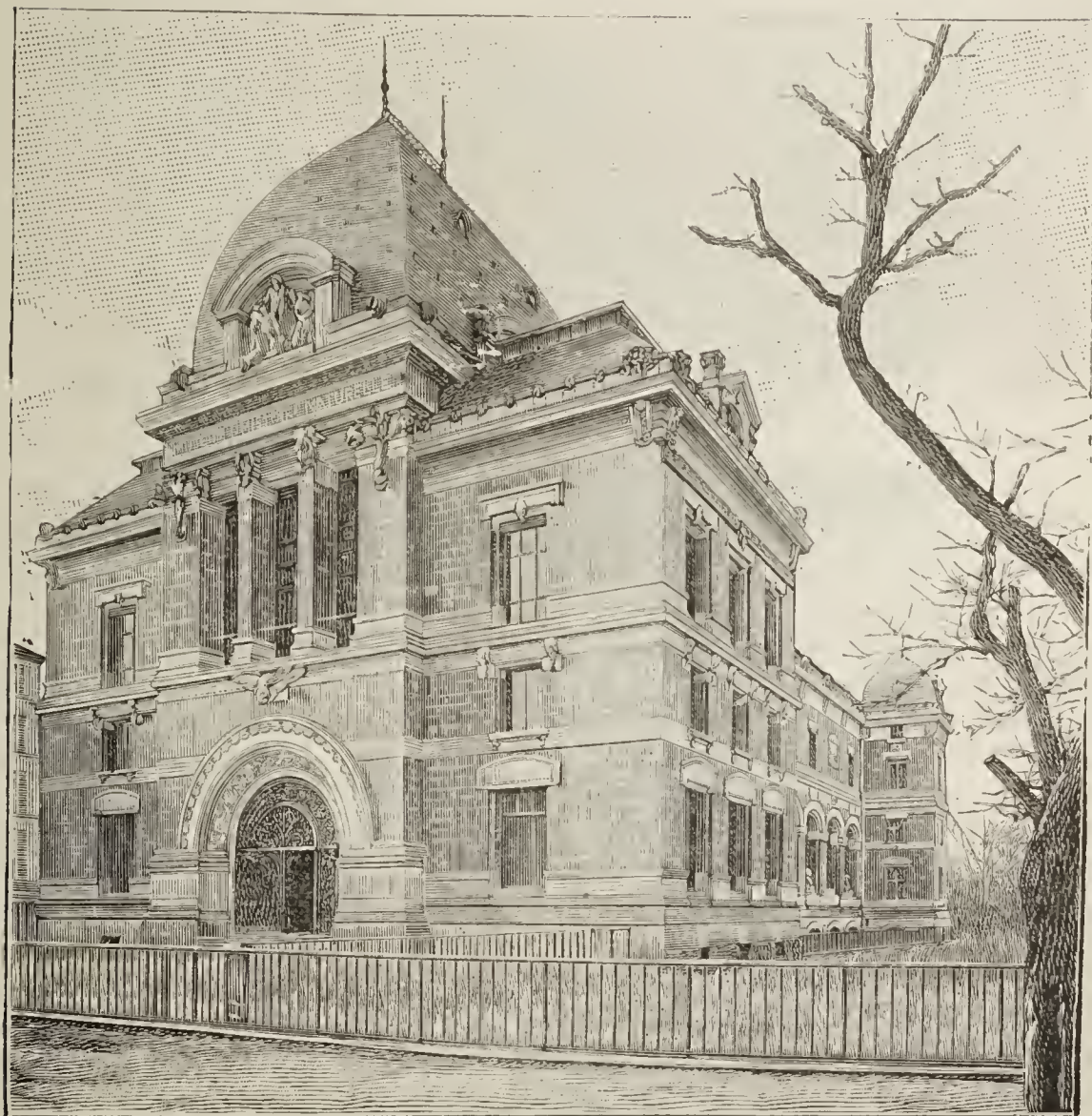
FIG. 1. — Façade des nouvelles galeries du Muséum(1).
