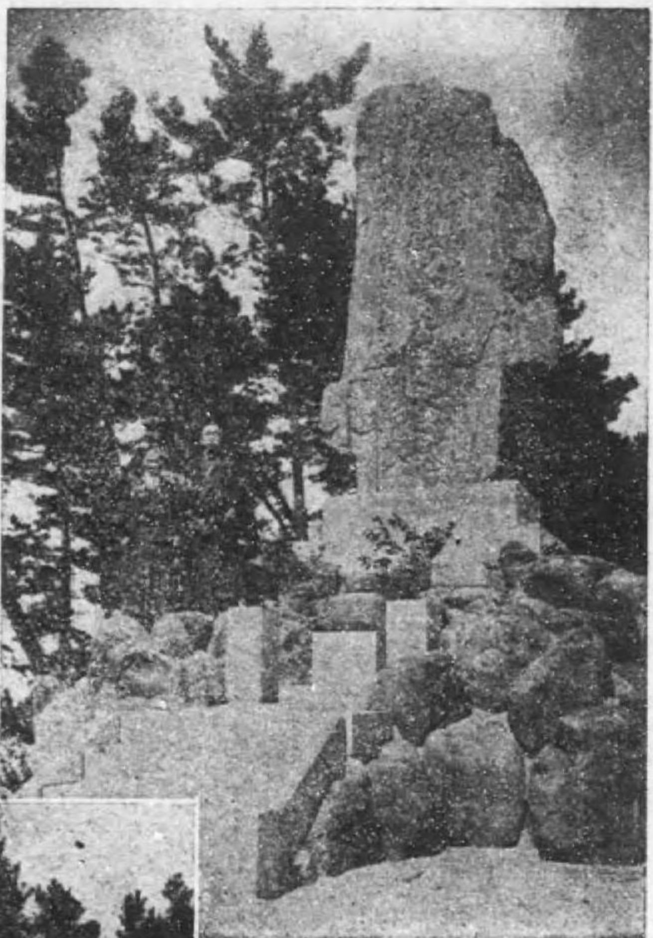
寫眞(下段) は蒙古軍大供養建設の地點の山上迄の參道として築造せる鐵骨コンクリーの階段にしてその長さ十六間餘あり、其基底より約三間の海岸に蒙古首切塚ありしも數十年前博多東公園元寇記念館に移さる。
