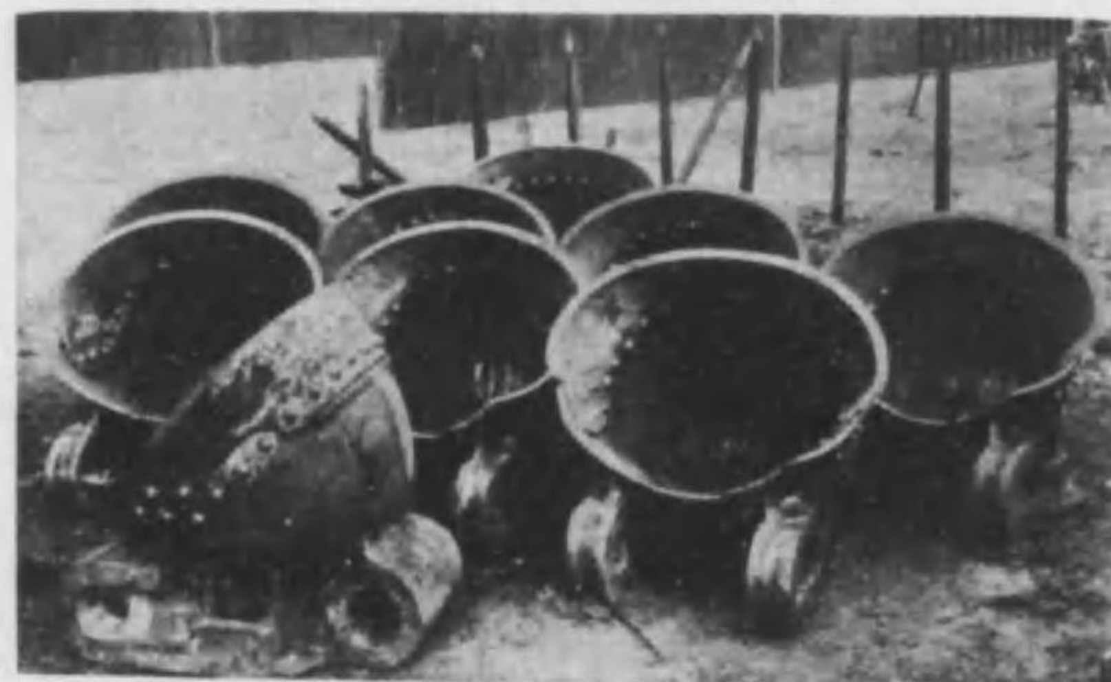
滿侖鋼製採砂金用バケツト重量一噸
