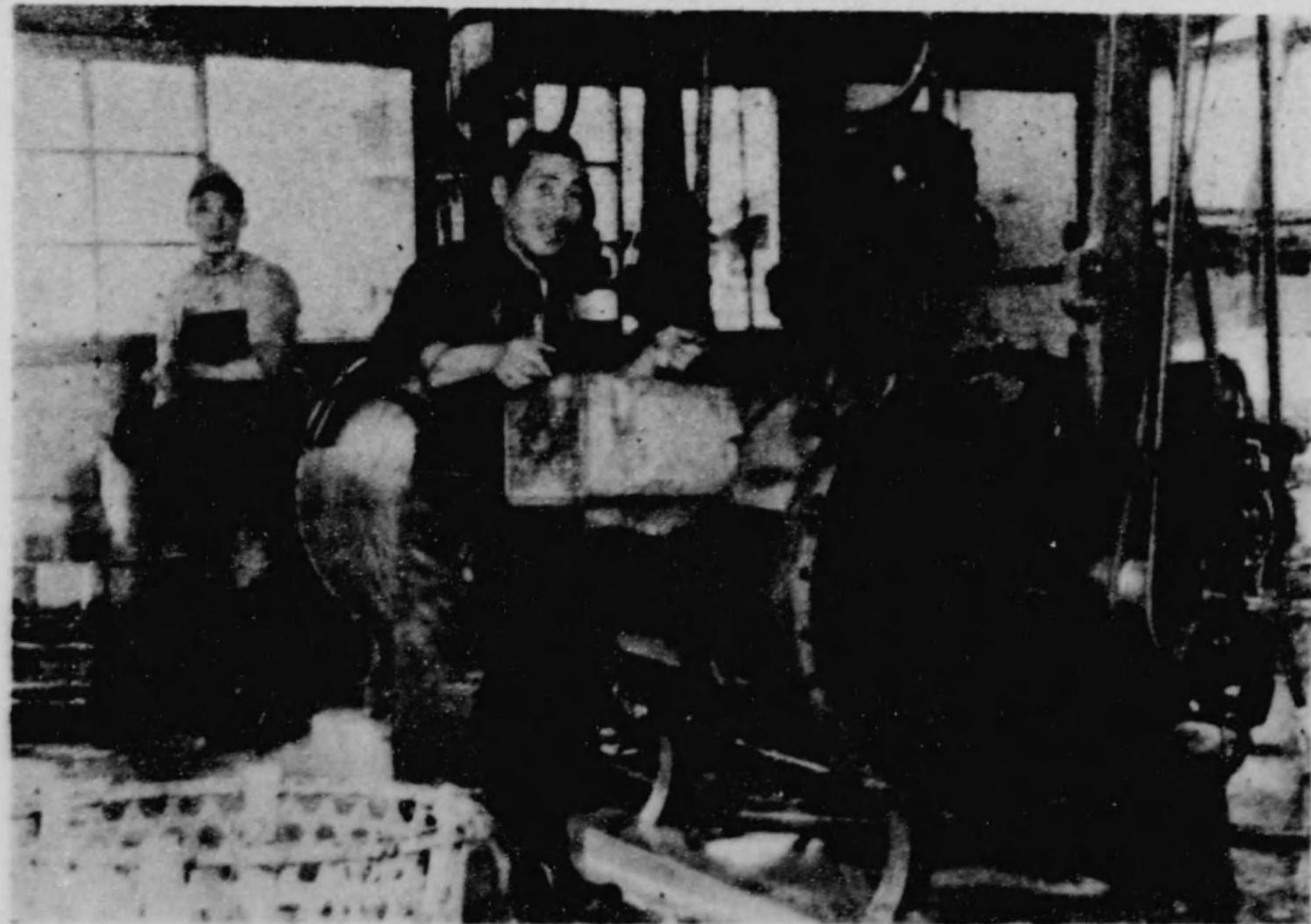
千日町作業館 洗濯實況
