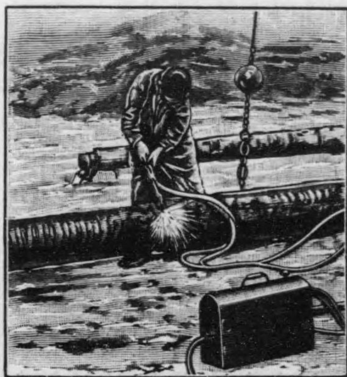
[79] アセチレンと酸素とを用ひて鐵管を切る。
