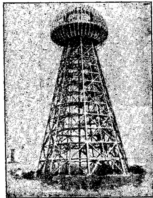
上圖爲著名之電力塔，建於 美國 長島，能傳送數千匹馬力之巨。設計建築的是 忒斯拉 氏。後於歐戰開始時拆毀。現該發明家特在 耐亞嘎拉 瀑布處計畫建築與此相似之鋼塔。
