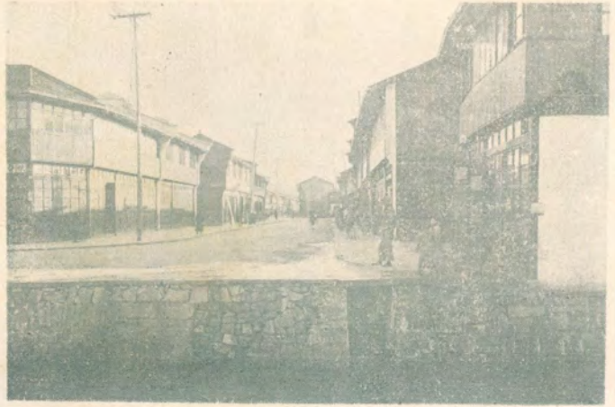
湖濱路鋪澆柏油路面施工情形
