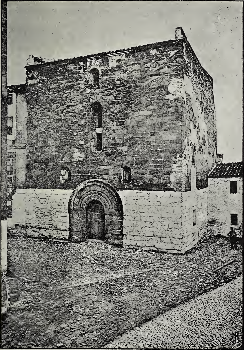
CASTILLO DE MONZÓN.—PUERTA DE LA CASA DE LOS TEMPLARIOS
