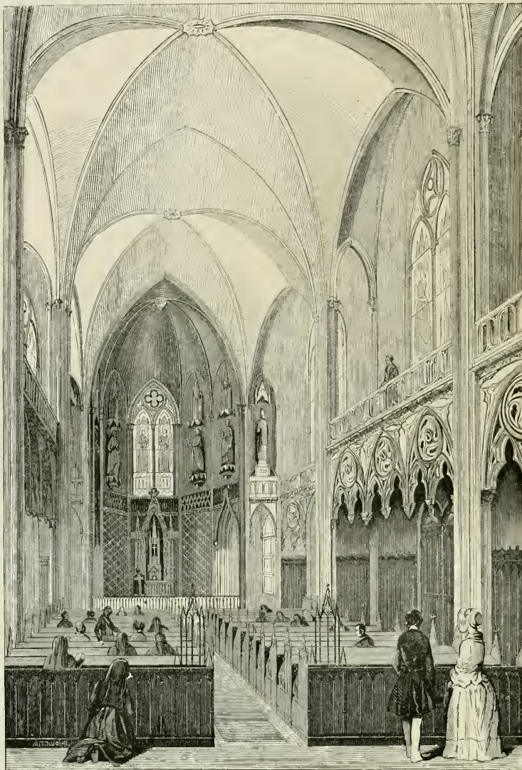
É (Vue intérieurs de la nouvelle chapelle du couvent des dames de Bon-Secours, rue Notre-Dame-des-Champs 12 bis, par M. Breton, architecte.)
