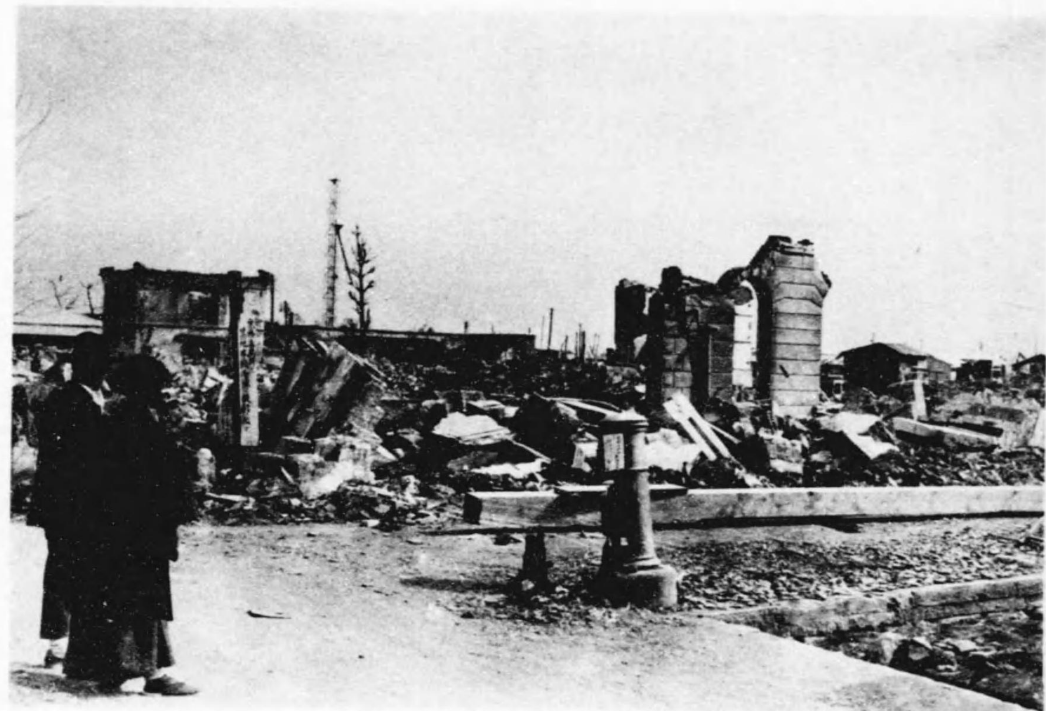
跡 失 燒 所 役 區 橋 京
