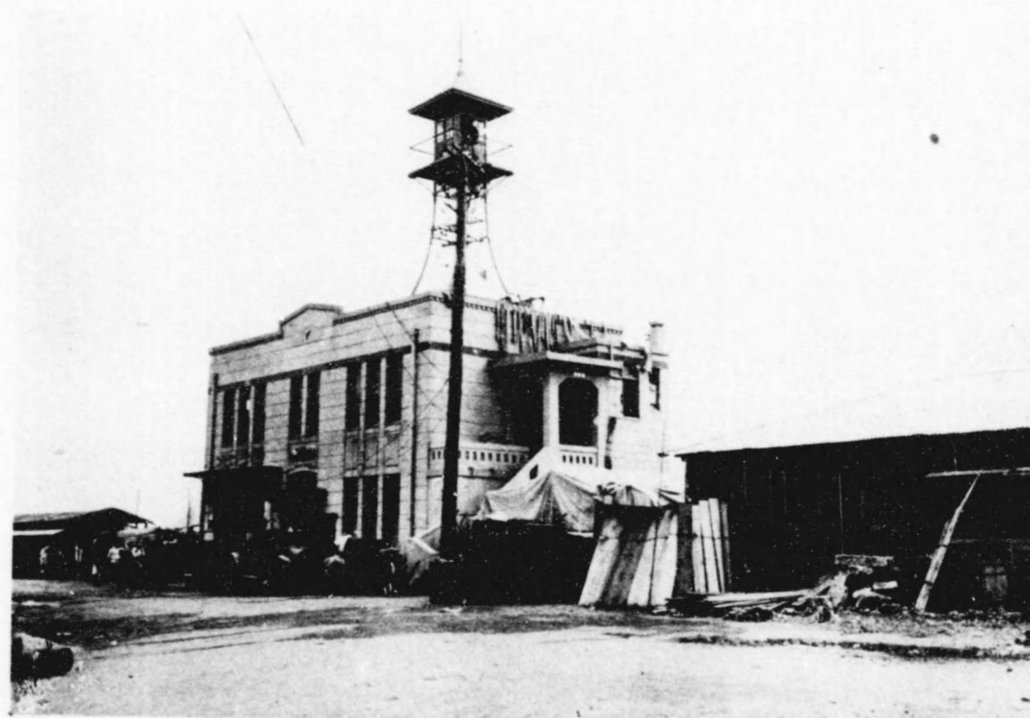
(日二十月十) 署防消崎洲川深
