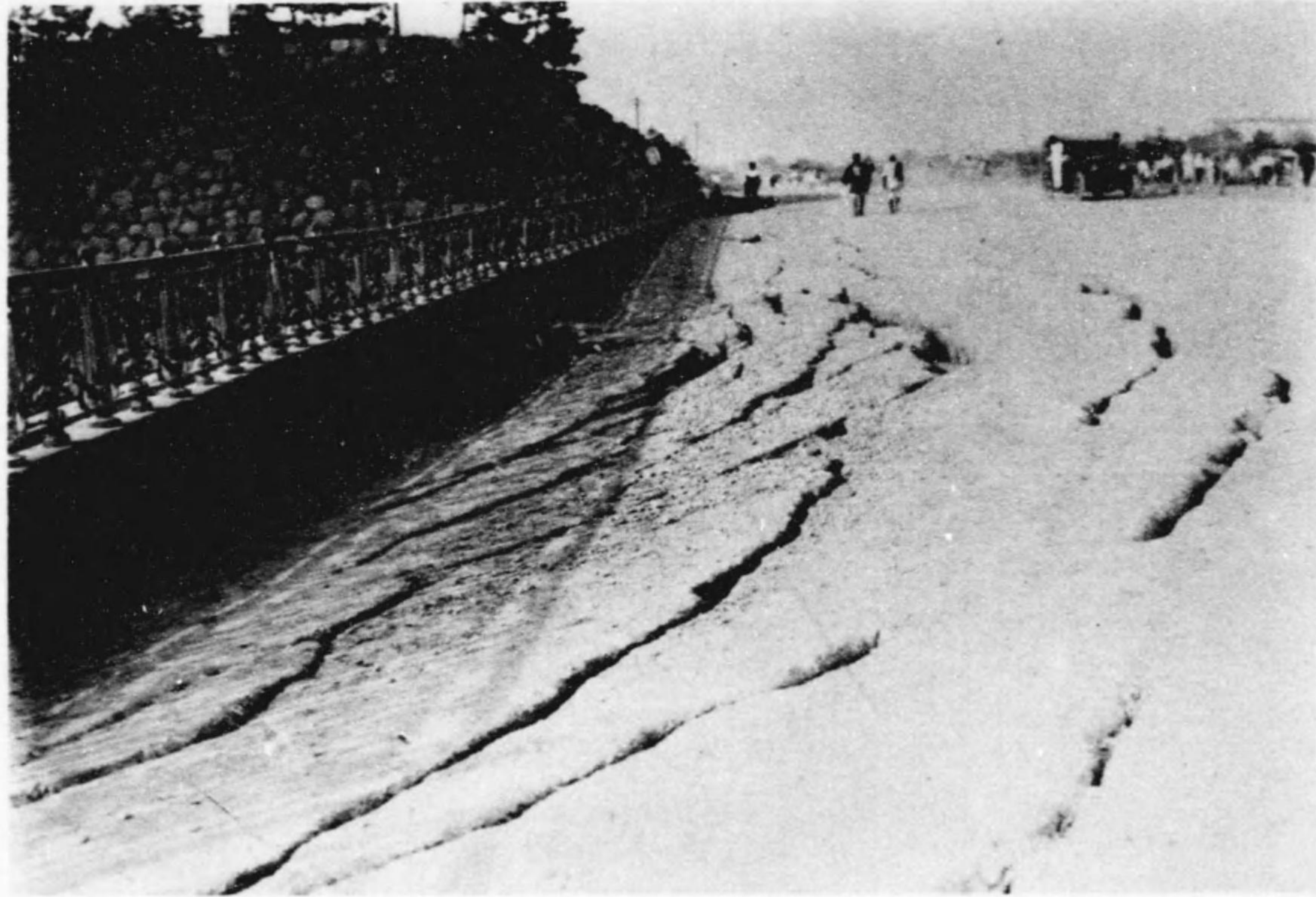
凱旋道路の亀裂
