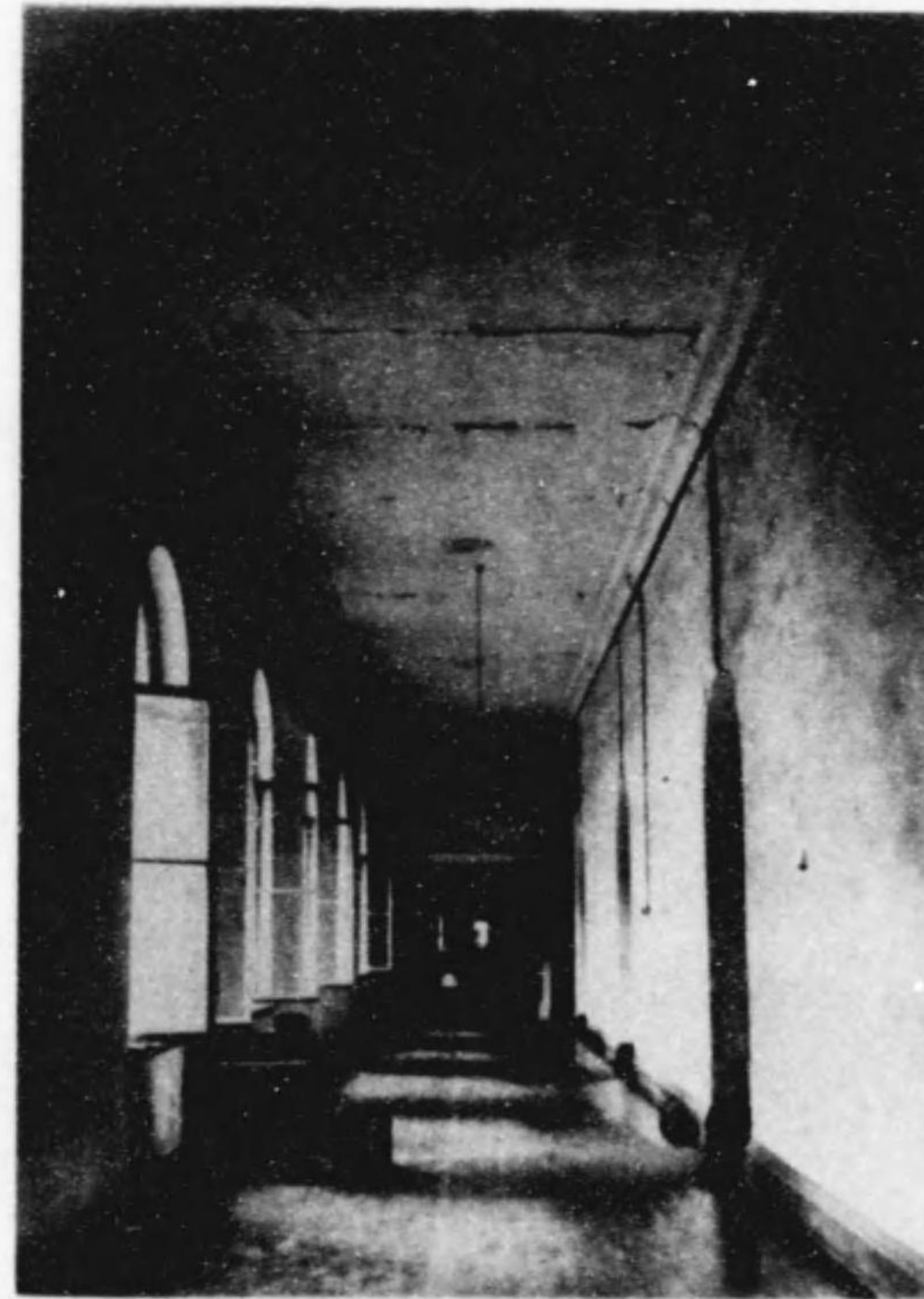
同上(二階廊下の天井)
