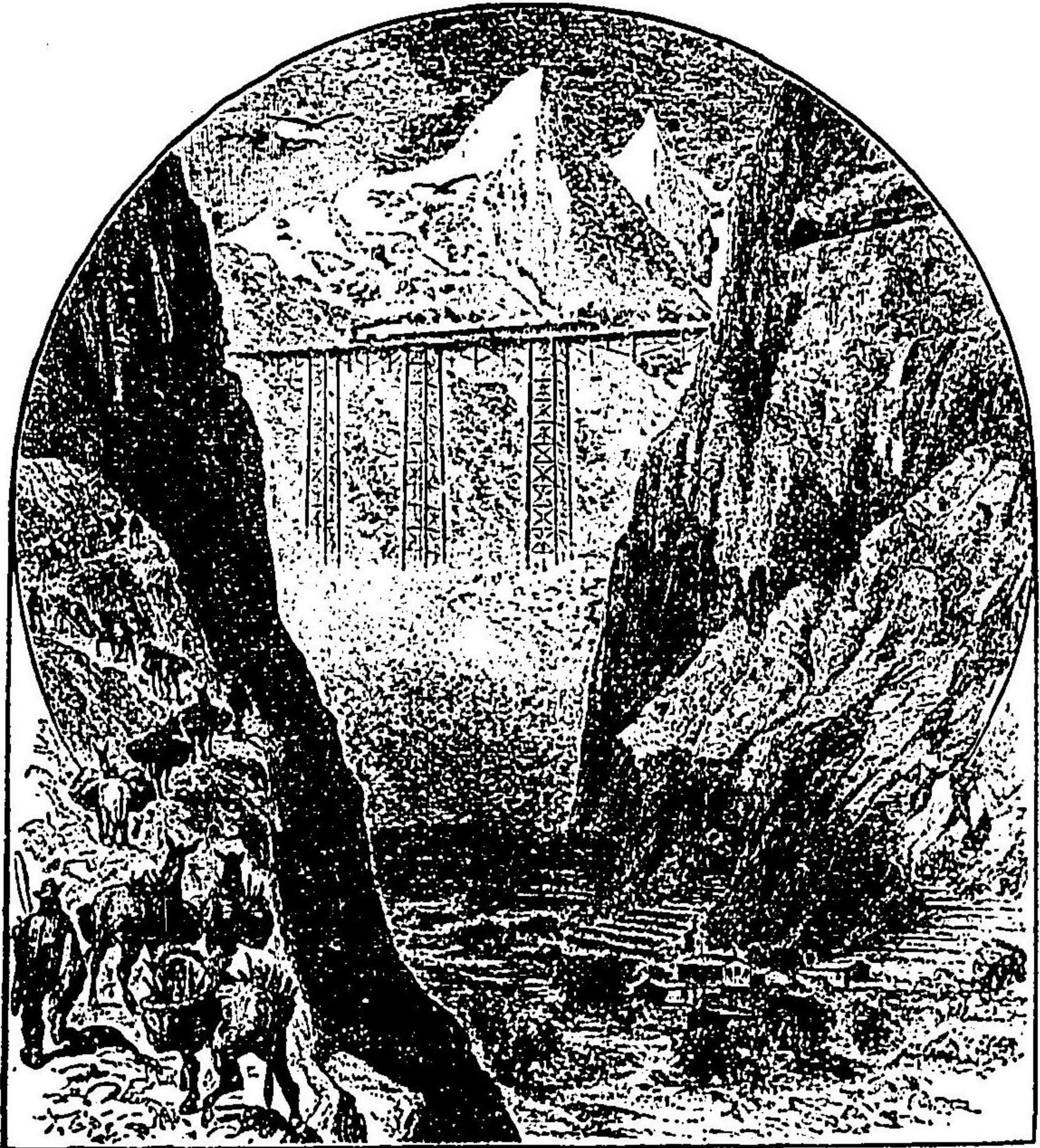
山中の輸送の状況
