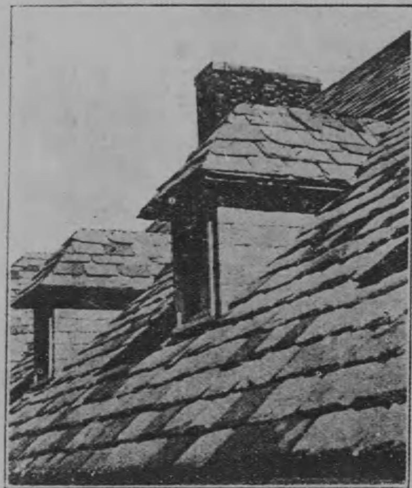
スレートの屋根
