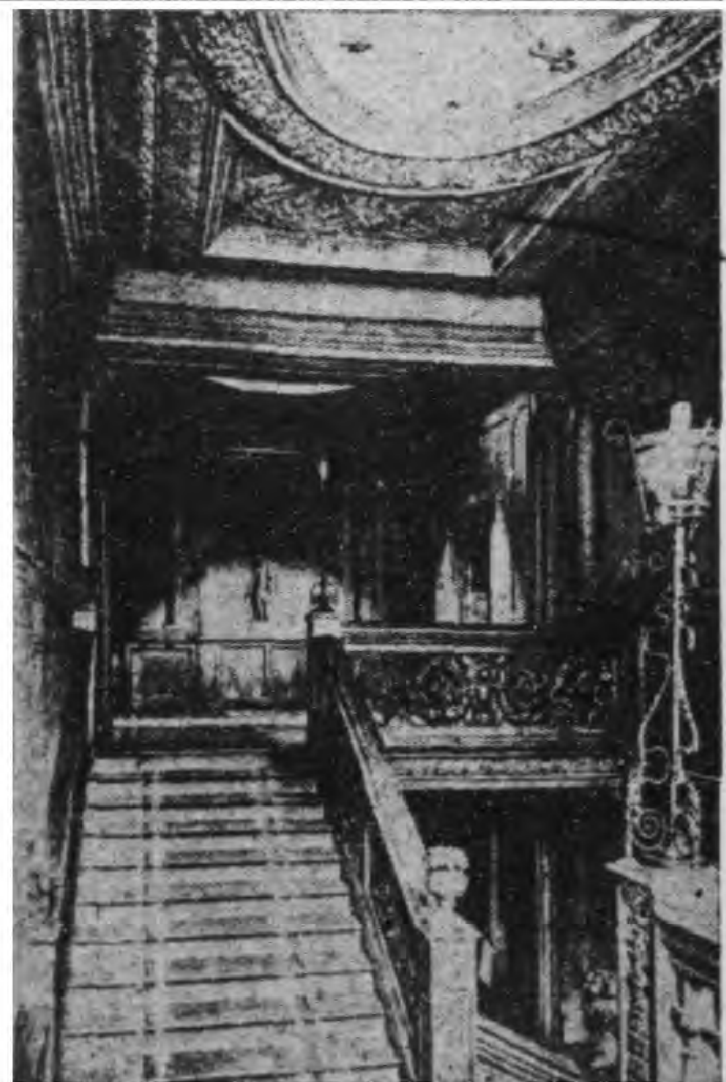
丁. 厄爾塔姆居宅(扶梯) 肯德
