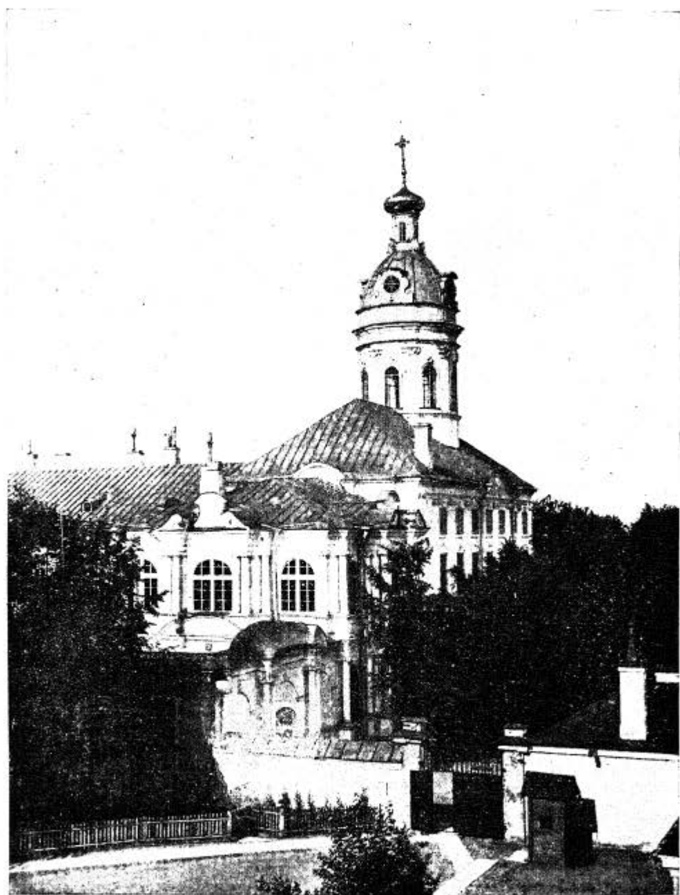
103. Верхняя Θεодоровская съ нижнею Златоустовскою церкви.
