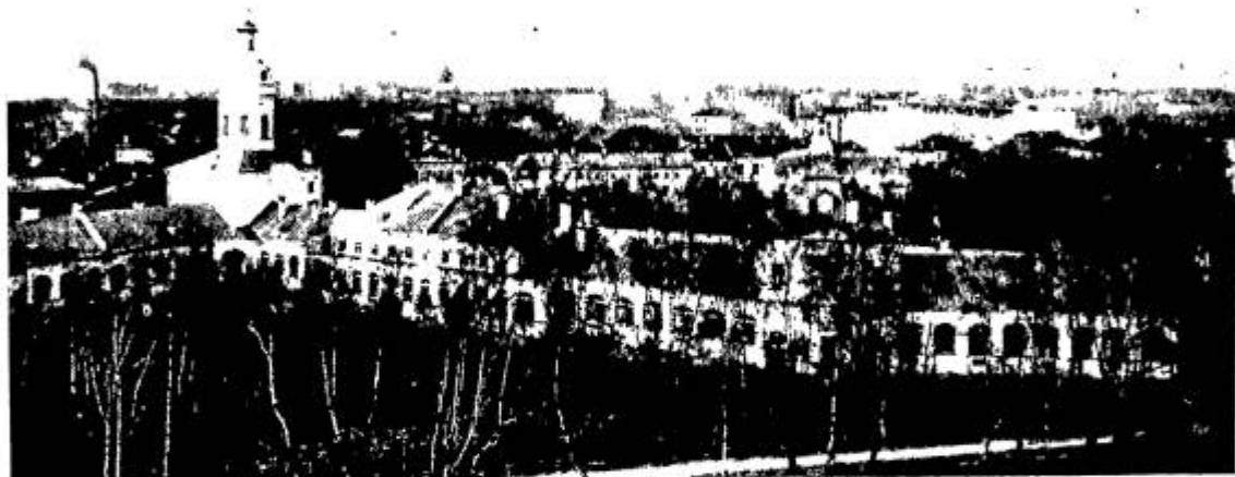
112. Сѣверо-Западная Башня и Сѣверный корпусъ.
