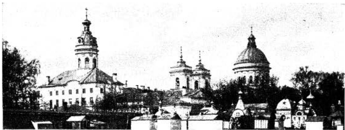
105. Феодоровская и Златоустовская, иныѣ Никольская и Феодоровская, церкви съ Юго-Восточнаго угла.
