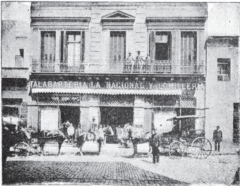
FACHADA PRINCIPAL DE LOS ALMACENES Y TALLERES
