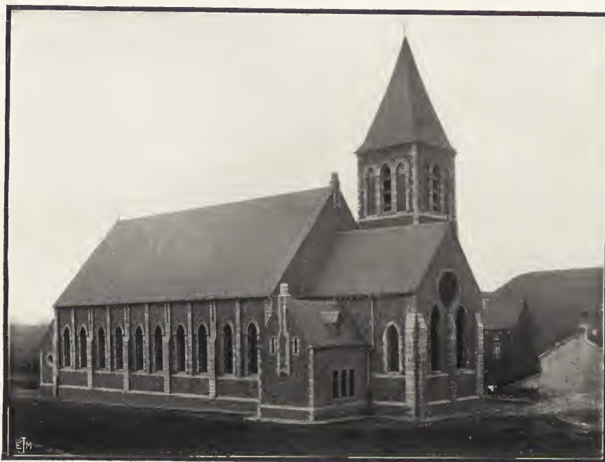
ÉGLISE DE BOUBIER. VUE SUD-EST.
