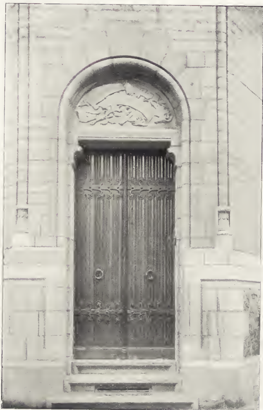
HOTEL DES TÉLÉPHONES A GAND. Arch. A. Van Houcke. PORTE D'ENTRÉE DE SERVICE.
