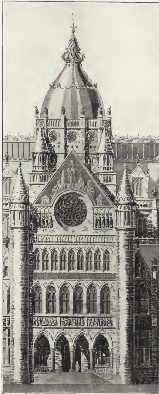
PIGNON VERS L'AVENUE DE LA JOYEUSE ENTRÉE.
