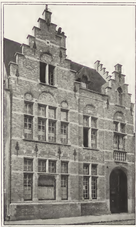
MAISON A L'EECKHOUT A BRUGES. Arch. Vierin.
