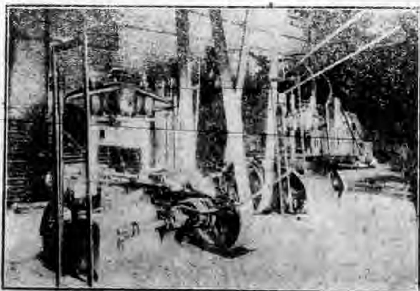
機 間 之 一 部 分
