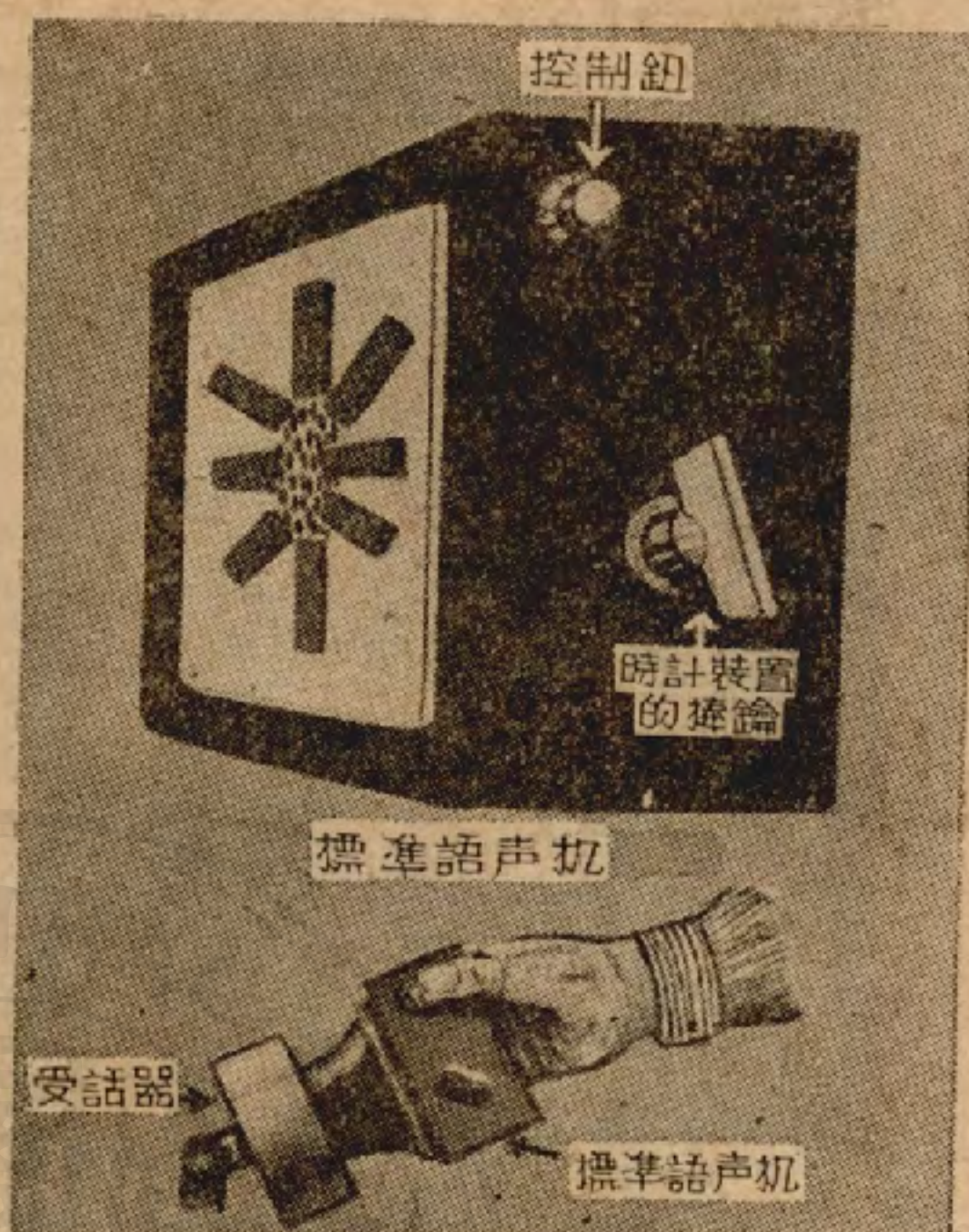
圖八 這一具小小的標準語聲機(Standard Voice Machine)用時鐘機關來發動。把控制鈕按下時，它會發出喃喃之聲好像有許多人同時說話一樣。用它所發各種的人聲。可給工程師們檢驗電話制的效率。
