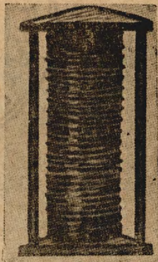
圖二 產生連續電流的最初方法，是 伏打 所發明。他造出第一只電池，稱為 伏打電池 。
