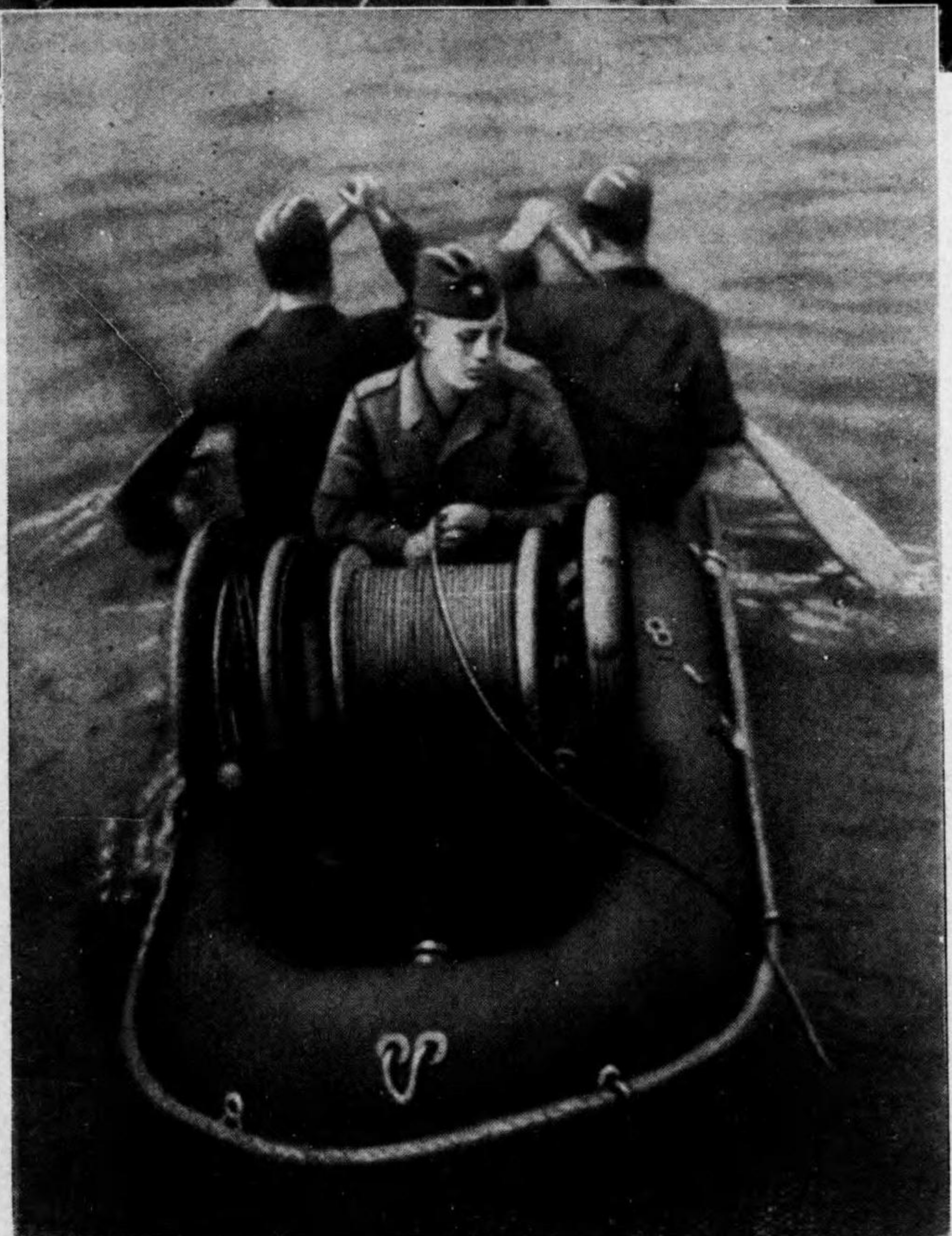
↑前線の觸角電氣通信(母國の便りを聴く)〔獨逸〕 ←ゴムボートに依る通信隊の電線布設〔獨逸〕
