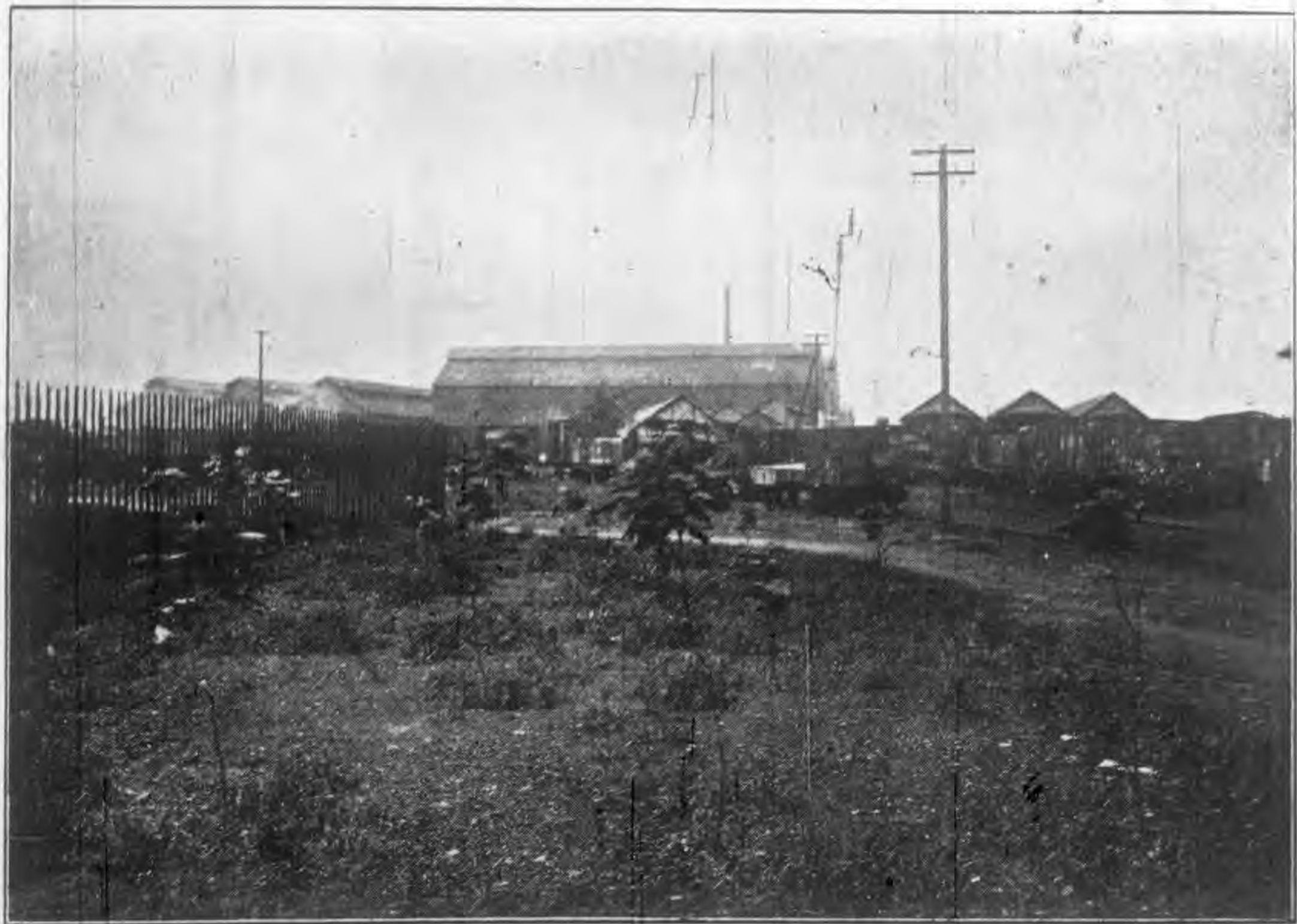
本路江岸機廠外景
