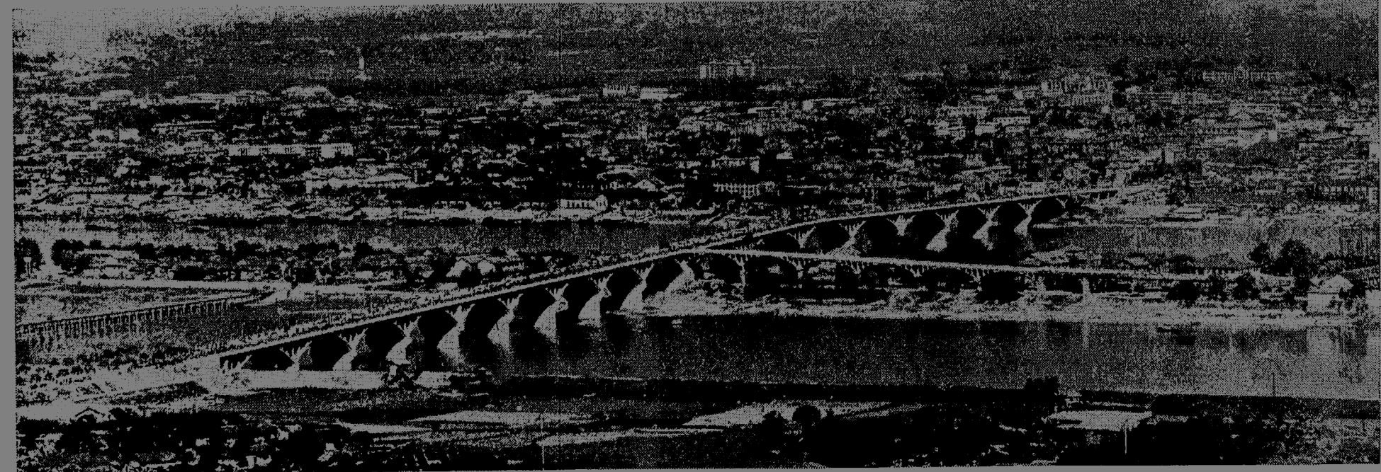
湘江大桥全景 本报记者摄
