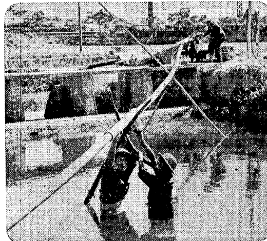
在抗旱关键时刻，桃源县和湘潭县磷肥厂采取联合行动，帮助附近社、队抗旱。这是工人们正在检修水管。
