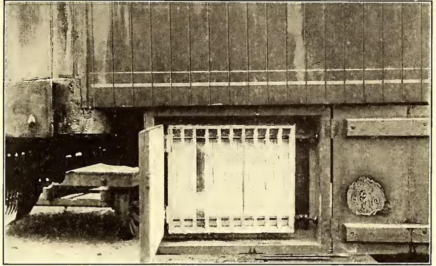
INSTALLATION OF LIGHTNING ARRESTER UNDER CAR
