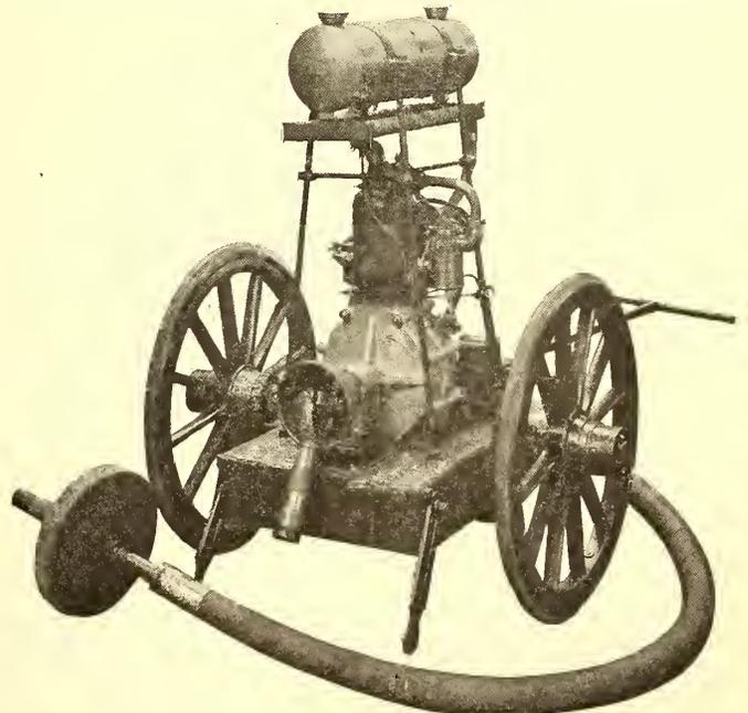
GASOLINE RAIL GRINDER AND DRILL
