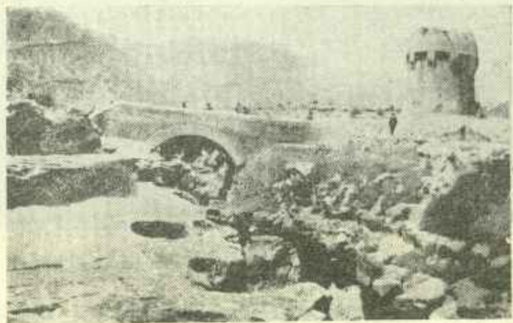
منظره پل تنك و برج آن از کنار
