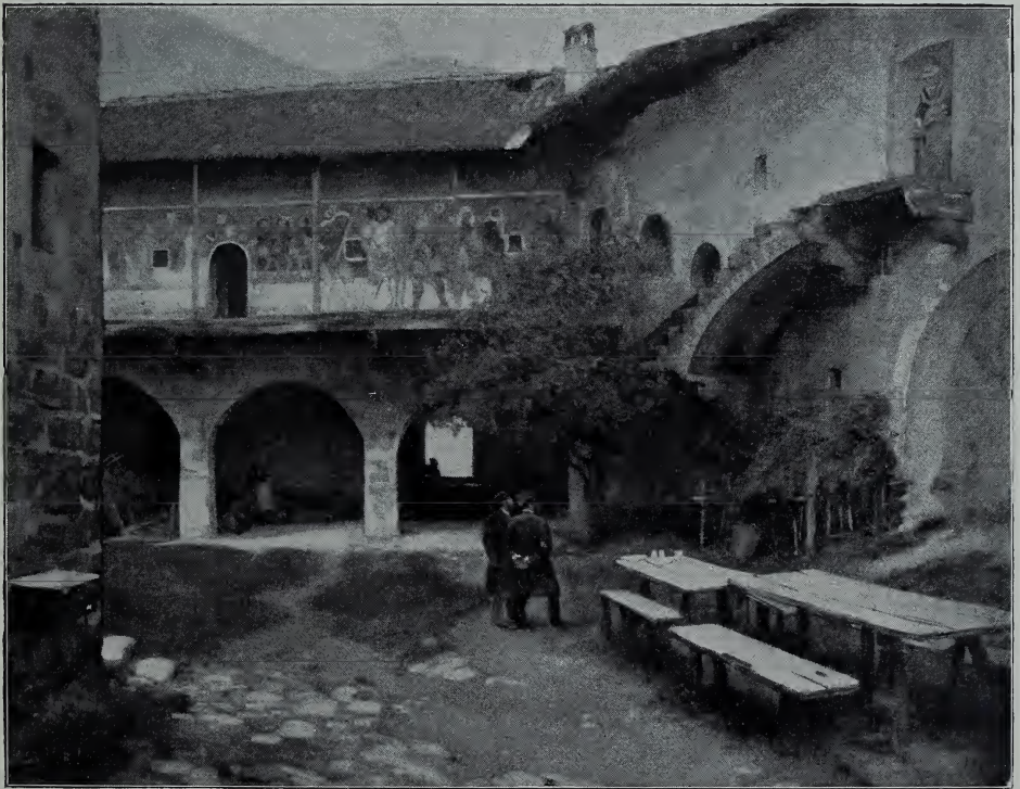
Abb. 25. Hof der Burg Runkelstein bei Bozen.
