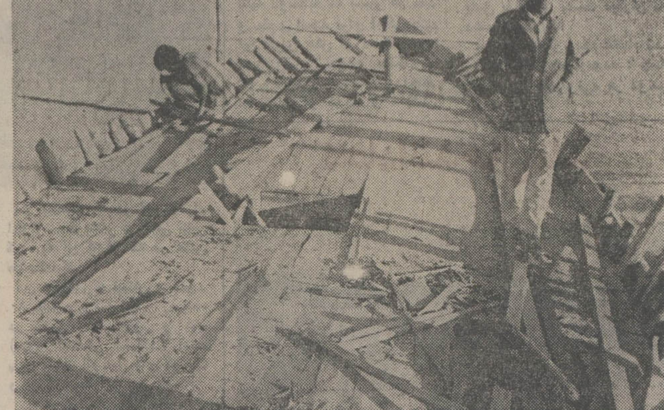
* پس از پایان گرفتن مراحل ساختن لنج کارگران با مهارت درزها و شیپهای بدنه و کف لنج را با نوعی پنبه مخصوص موسوم به «گفسات» بر می کنند. این کار باعث خواهد شد که آب به داخل لنج نفوذ نکند.
