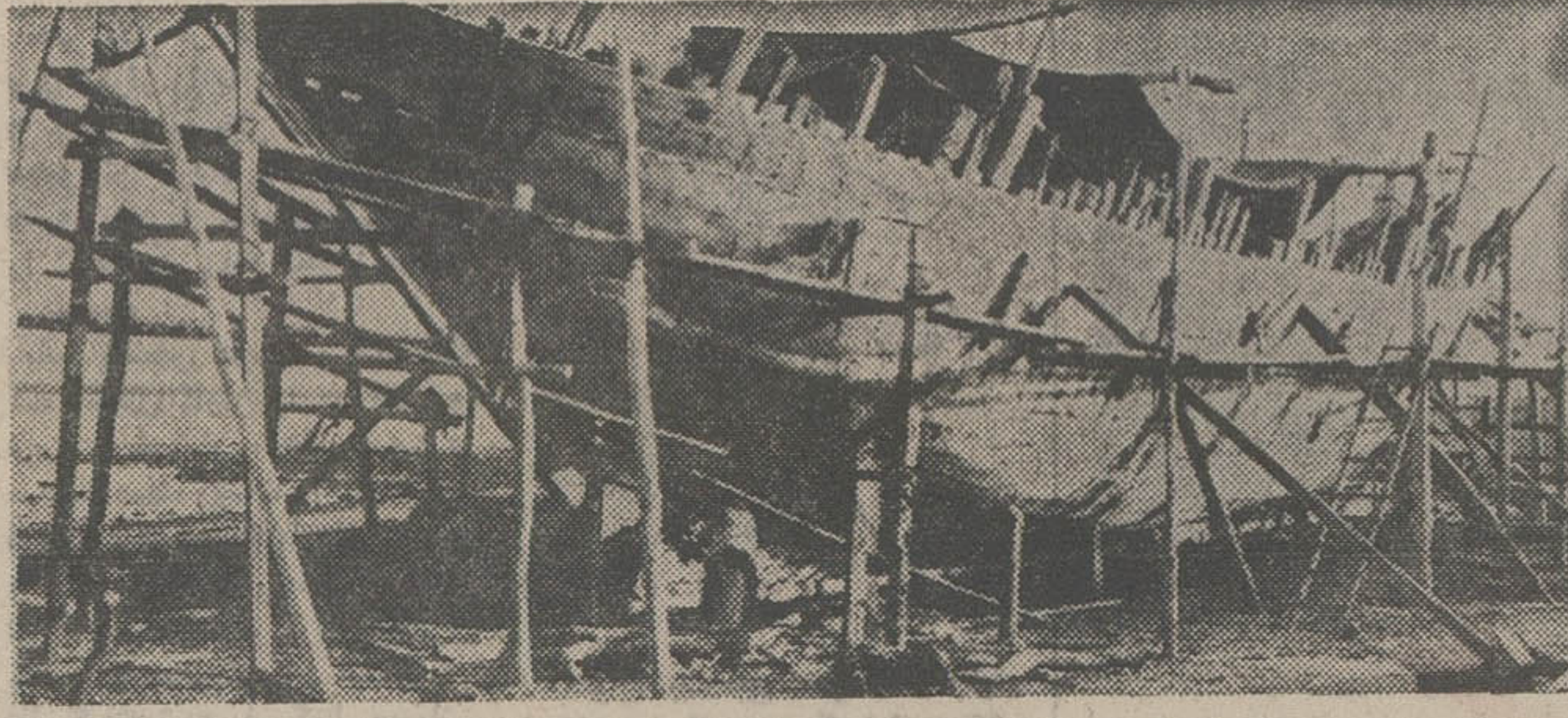
* این تصویری از یک لنج نیمه تمام و نسبتاً بزرگ است. چنین لنجی با صرف وقت زیاد و با همان ابزار و وسایل اولیه ساخته می شود و در برابر استحكام و ظرفیت قابل ملاحظه ای برخوردار است.
