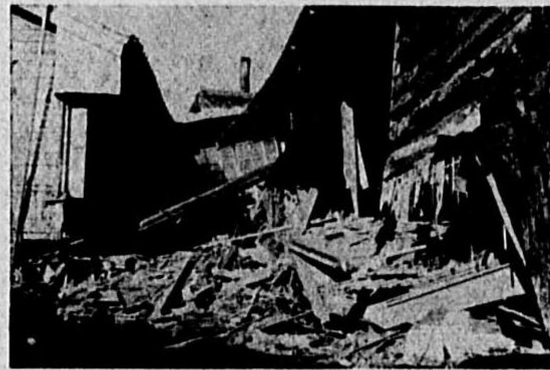
(津浪ノ水勢ニテ腰部ヲ破壊セラレ倒潰セル 家屋)
