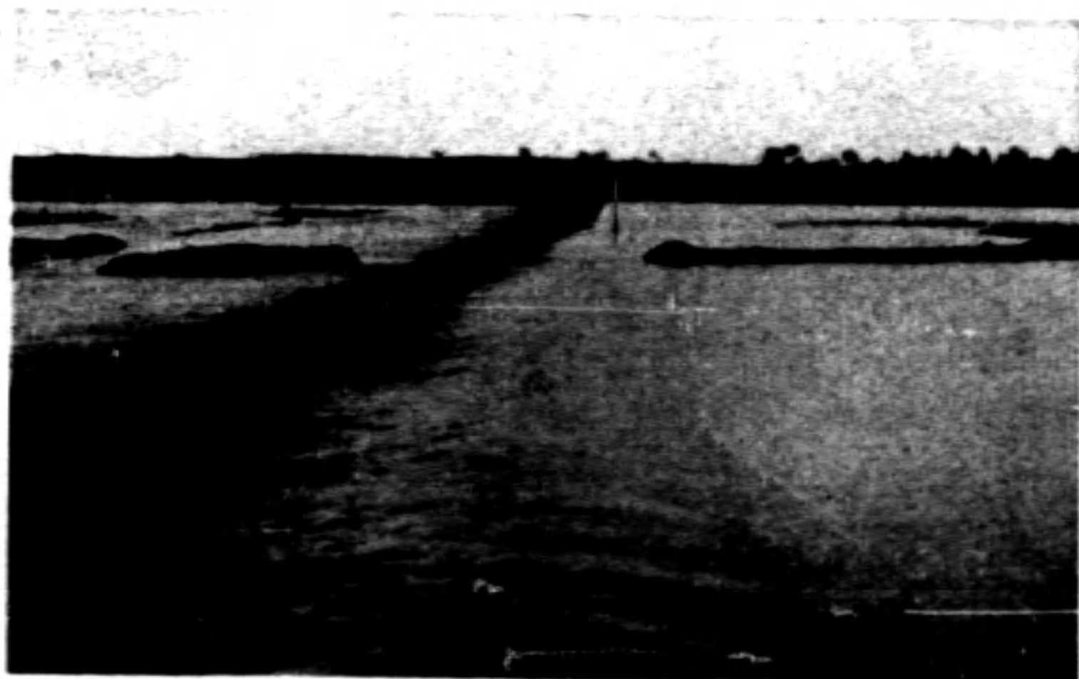
影(12)攔水堰頂過水情形 (水深約2公寸)
