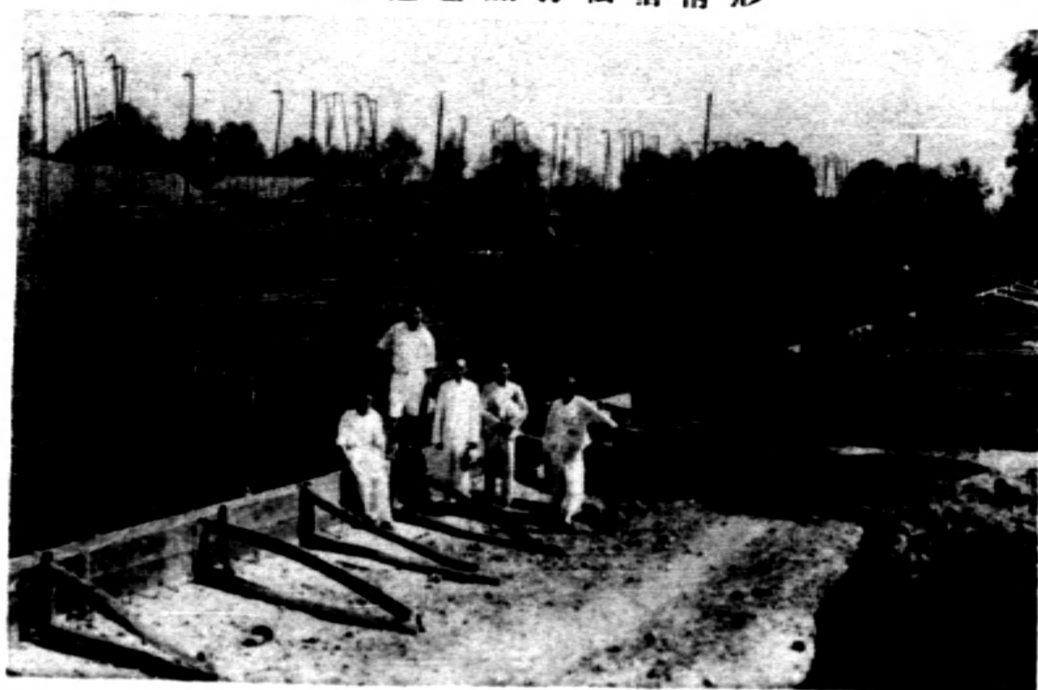
(10) 池底及池牆繫鐵情形
