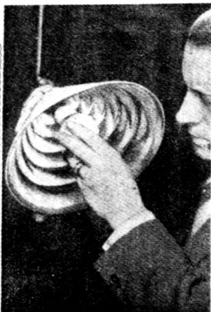
(甲式) 普通之燈罩，其反光方向較他種爲強，然罩內面以鏡以，小鏡，其反光力更巨，製法如圖，
