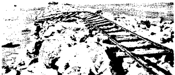
圖八 南沙壩上軌道相繼被潮沖毀，嗣以鉛絲縛軌固於石，其患稍戢。(十八年八月)
