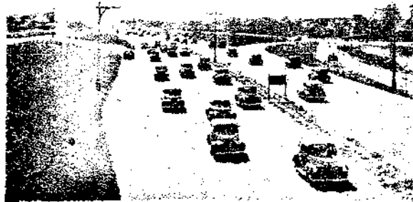
圖二 1940年紐約附近之超級公路，車道六條，三去三來，路中植以花木，隔離燈光，並示如何引進與引出車輛。
