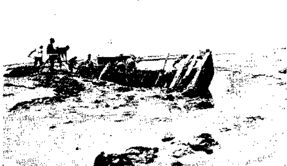
圖七 緒山護岸運石船沉覆，為沙泥所掩，此為打撈時之情形。(十八年四月)
