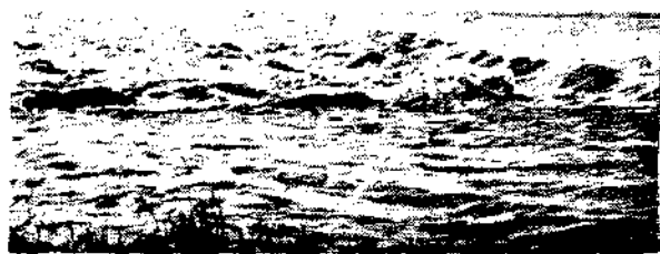
圖十 二十二年九月十日(陰曆七月二十一日)潮勢較小，箭頭所示為潮流方向，甲甲為潮水翻過B壩成浪情形，乙乙洶湧異常，乙丙為新沖之溝，其下無石，故無翻浪。
