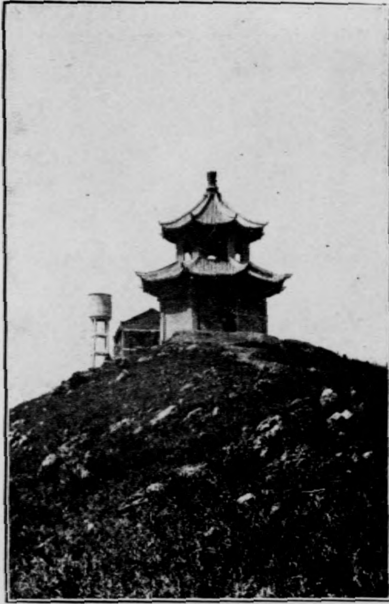
珞珈山巔之自來水塔
