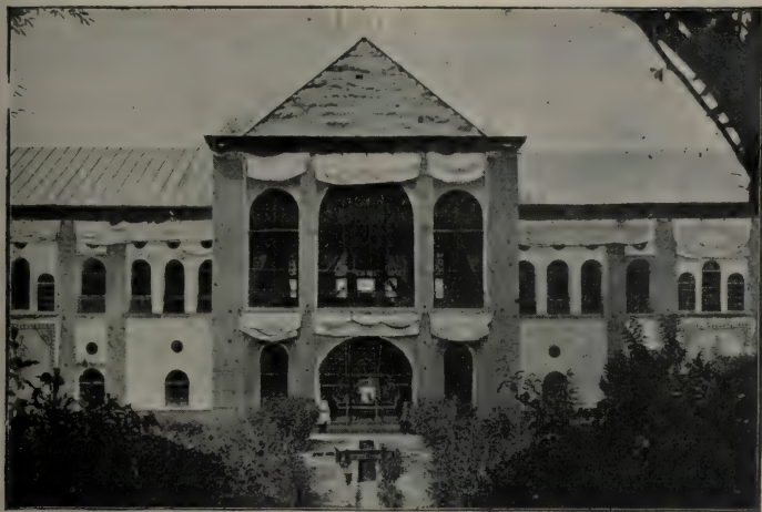
Façade nord du palais de Sahabkranie.
