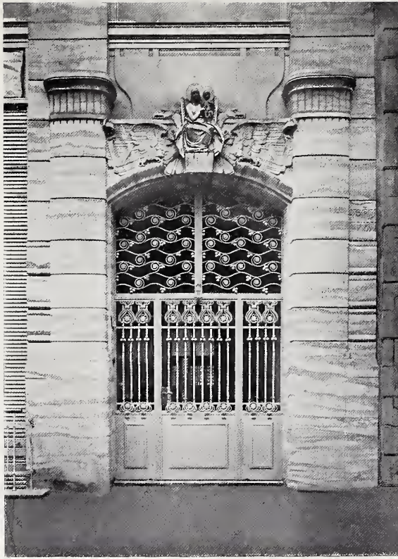
JAN KOTĚRA. PORTÁL DOMU V PRAZE. —
