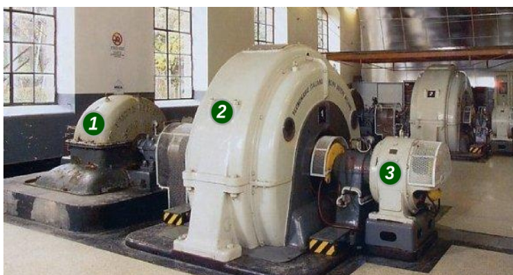
Fig. 186: 1) turbino - 2) generatoro - 3) ekscitanta generatoro
