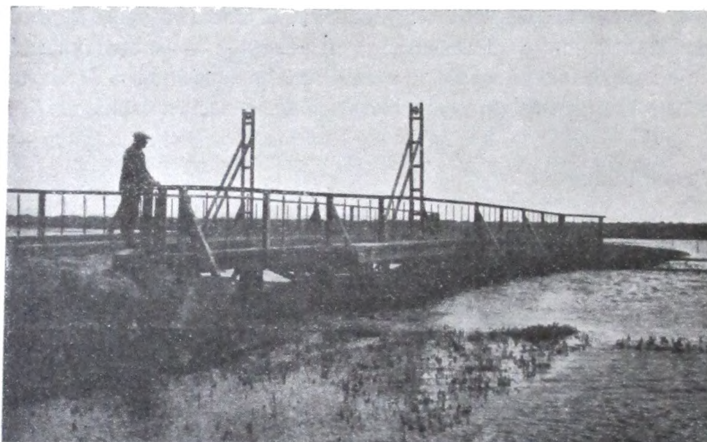
Desagües del Sud. — Puente levadizo, Hectómetro 602 del Canal N° 9.
