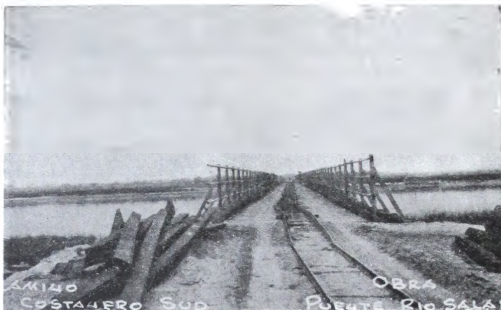
Camino Costanero del Sud. Puente sobre el río Salado
