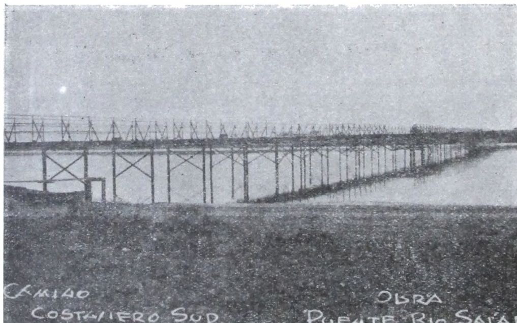
Camino Costanero del Sud. Puente económico sobre el río Salado
