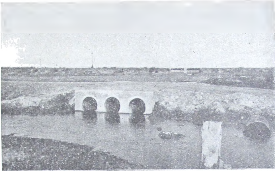
Bahía Blanca. Camino de Villa Olga. Alcantarilla de tres caños de cemento de 0m. 60 sobre el arroyo Saladillo.
