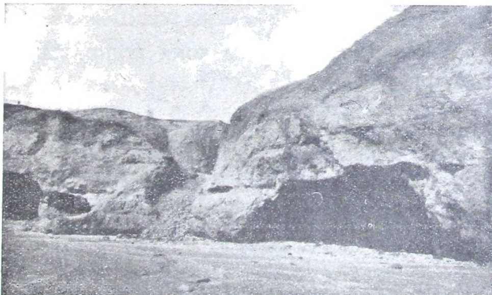
Mar del Plata. — Defensa del camino a Camet. Vista que muestra la avanzada destrucción de la barranca en la prolongación de la calle 28. 10 de noviembre de 1933.
