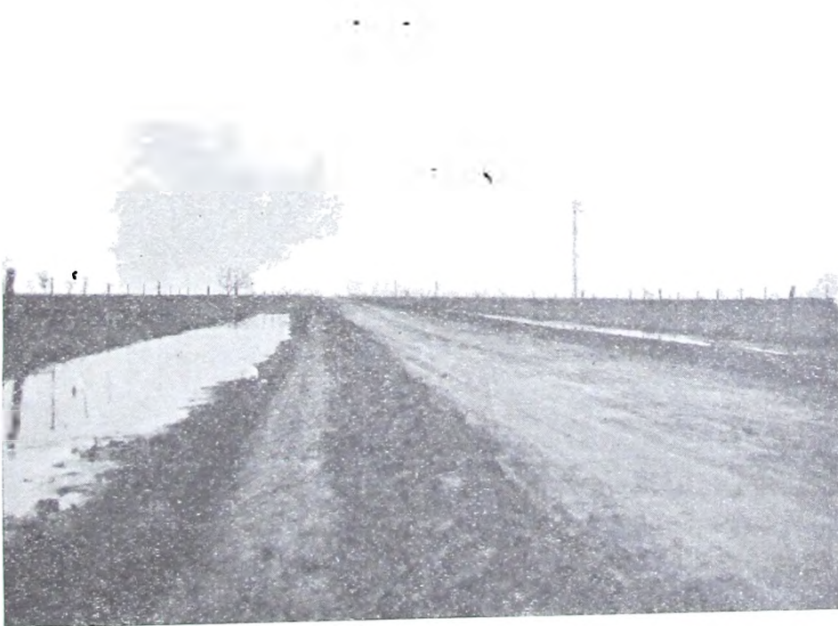
Camino de Bragado a Nneve de Julio; tramo Bragado - Olascoaga. Mejora del abovedamiento.
