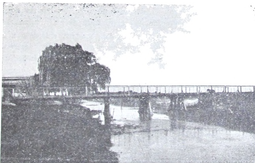
Desagües del Sud. — Puente sobre el Canal de Lynch. Partido de Castelli.
