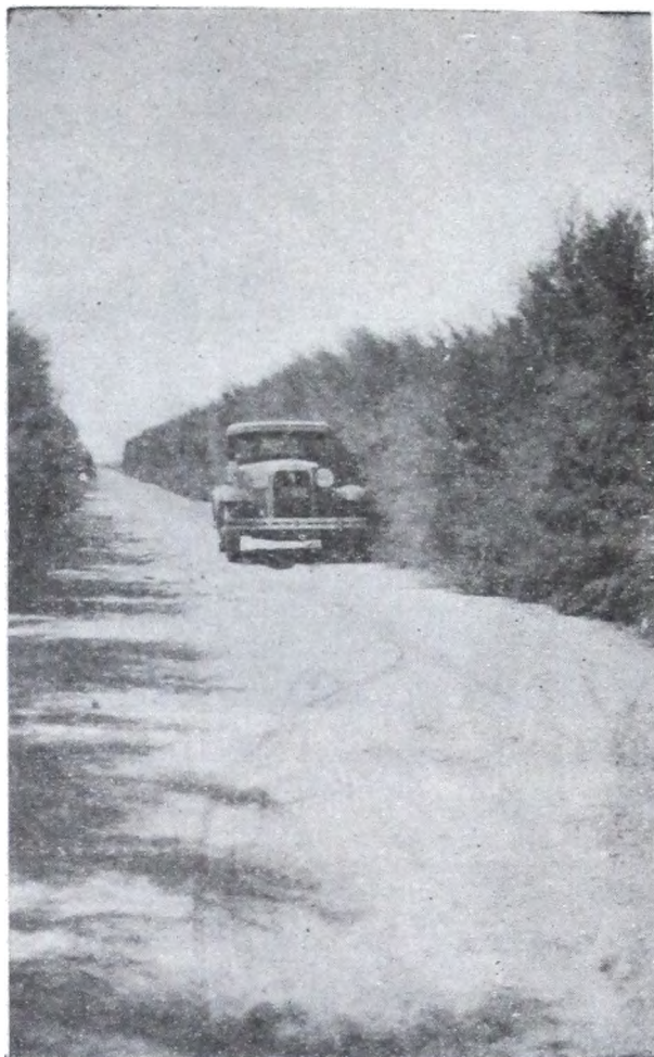
Terraplén fijado con plantaciones de tamarisco, característico de la zona arenosa de Trenque Lauquen y Pellegrini.
