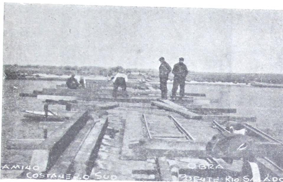
Camino Costanero del Sud. Un aspecto de la construcción del puente sobre el río Salado.
