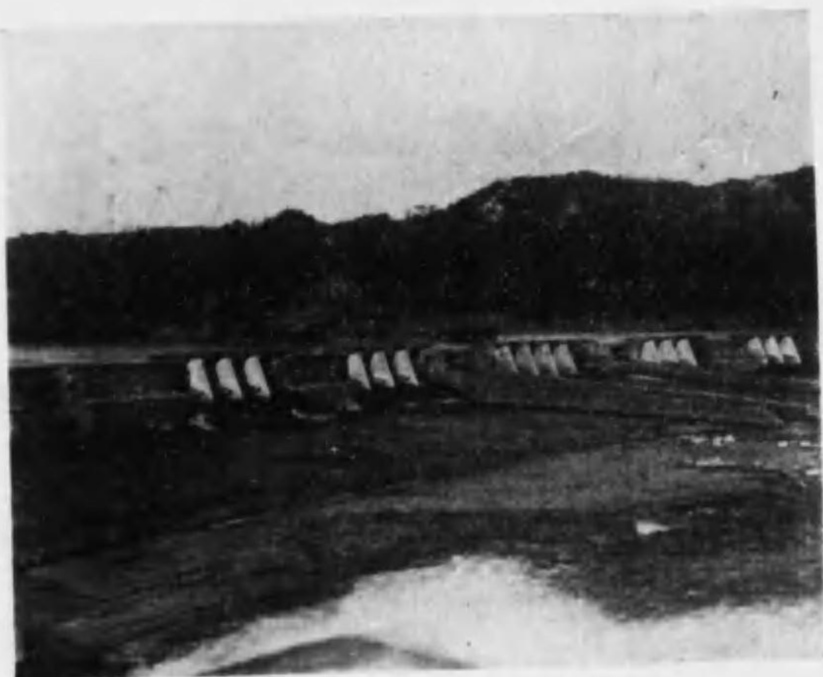
明治用水源大地堰 所在地西加茂郡母町大字今
