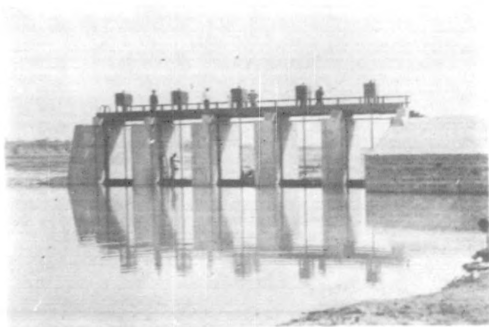
南洩水閘下門蓄水情形
