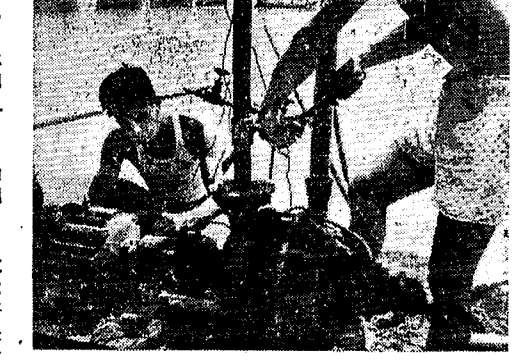
湘阴洞庭湖机械排灌站抗旱中见闻。这是他在为洞庭湖机械排灌站安装水泵。
