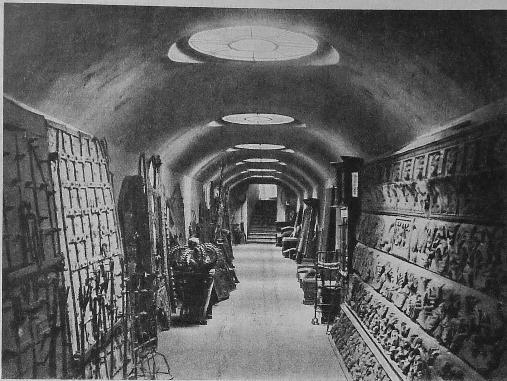
Тоннель, соединяющій новое зданіе Щукинскаго музея со старымъ.
