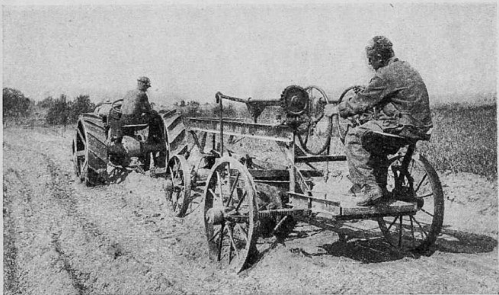
Придание дороге выпуклого профиля посредством „струга“ с тракторной тягой.
