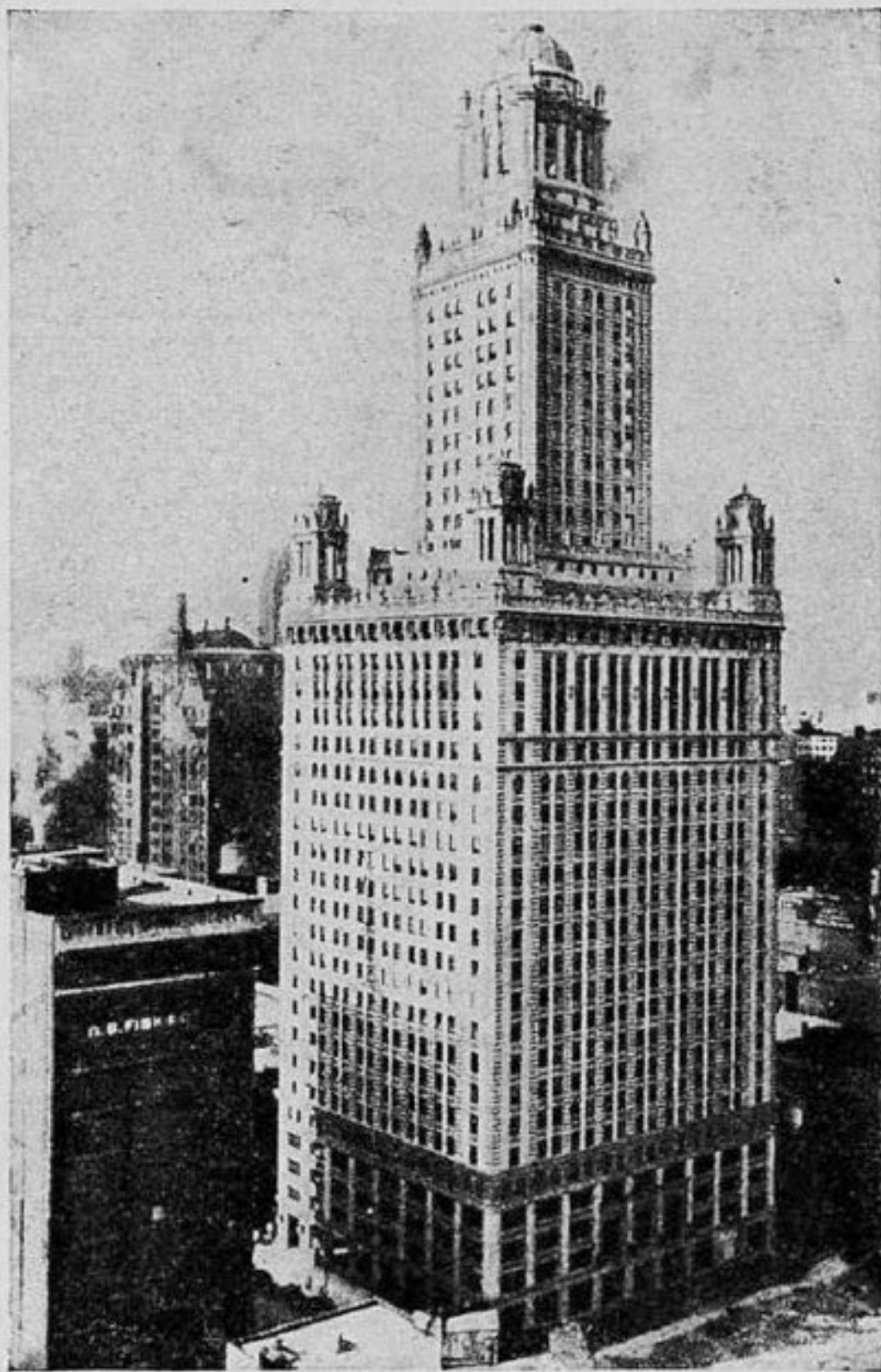
Гараж в 40 этажей в Нью-Йорке. В 23 нижних этажах имеется 550 боксов (помещений для автомобилей), в 17 верхних — деловые помещения. В подвальном этаже — помещения для чистки и ремонта. Автомобили поднимаются наверх специальными подъемниками
