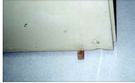
① 고장난(제거된) 도어클로저 ② 썬기설치(또는 도어 스톱 설치)
