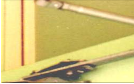
① 고장난(제거된) 도어클로저 ② 썬기설치(또는 도어 스톱 설치)
