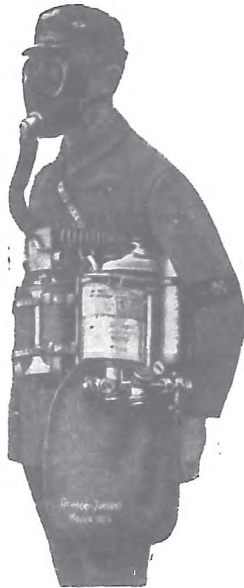
附圖 48. 維革 (Dräger) 式之氣體防護器具，自 1924 年模型之自救器 (備有面具呼吸者) 與過濾器 (尋常工業用之吸收罐或大號之吸收罐) 聯合而成，且備有呼吸改換箱以便自氧氣呼吸改爲過濾呼吸及作相反之改換者。
